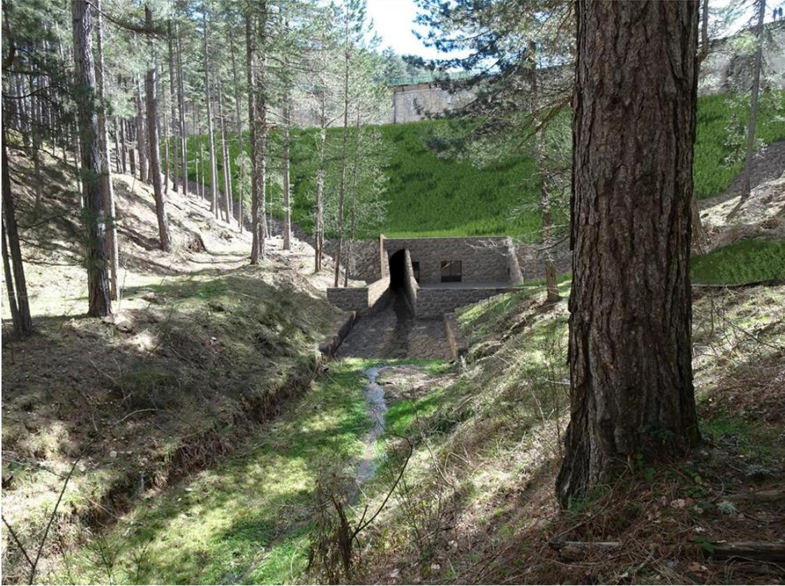
**fotosimulazione del nuovo rilevato in materiali sciolti con copertura in terreno vegetato e pietrame al piede, nuova cabina di comando delle paratoie dello scarico di fondo, uscita dello scarico di fondo e fondo alveo in pietrame**
