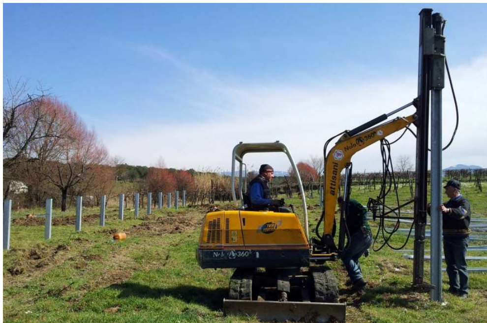
Figura 4 - Tecnica di realizzazione fondazioni Tracker
