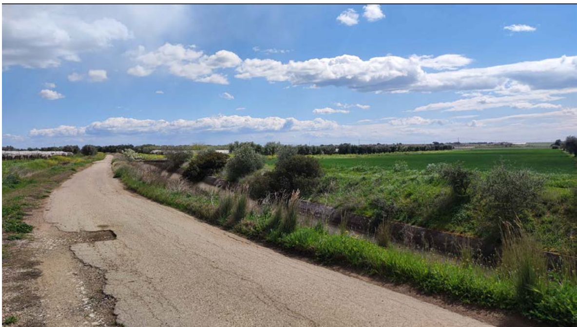
Figura 19 vista da nord della strada di servizio del canale di bonifica di competenza "Consorzio di Bonifica Stornara e Tara ante operam "impianto blocco 4"
