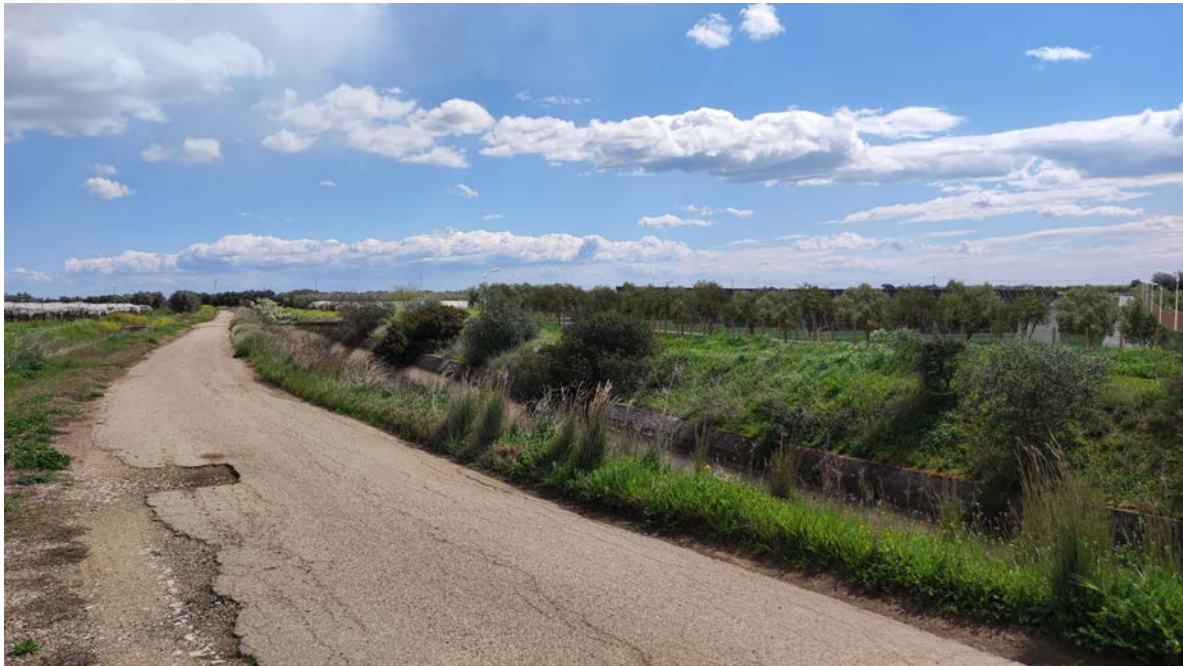
Figura 20 vista da nord della strada di servizio del canale di bonifica di competenza "Consorzio di Bonifica Stornara e Tara post operam "impianto blocco 4"
