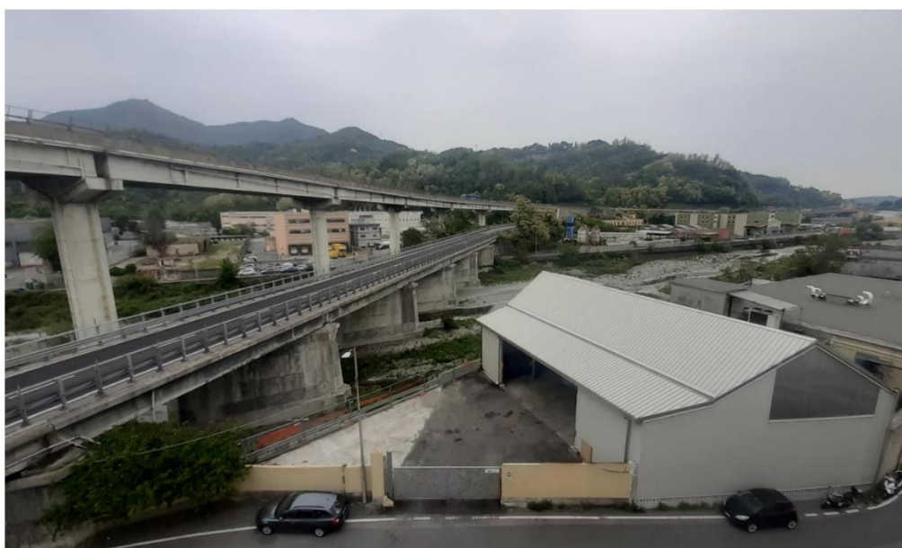
Figura 3-3. Ambito Bolzaneto: vista dalla sponda dx del torrente Secca e dei viadotti Secca esistenti
