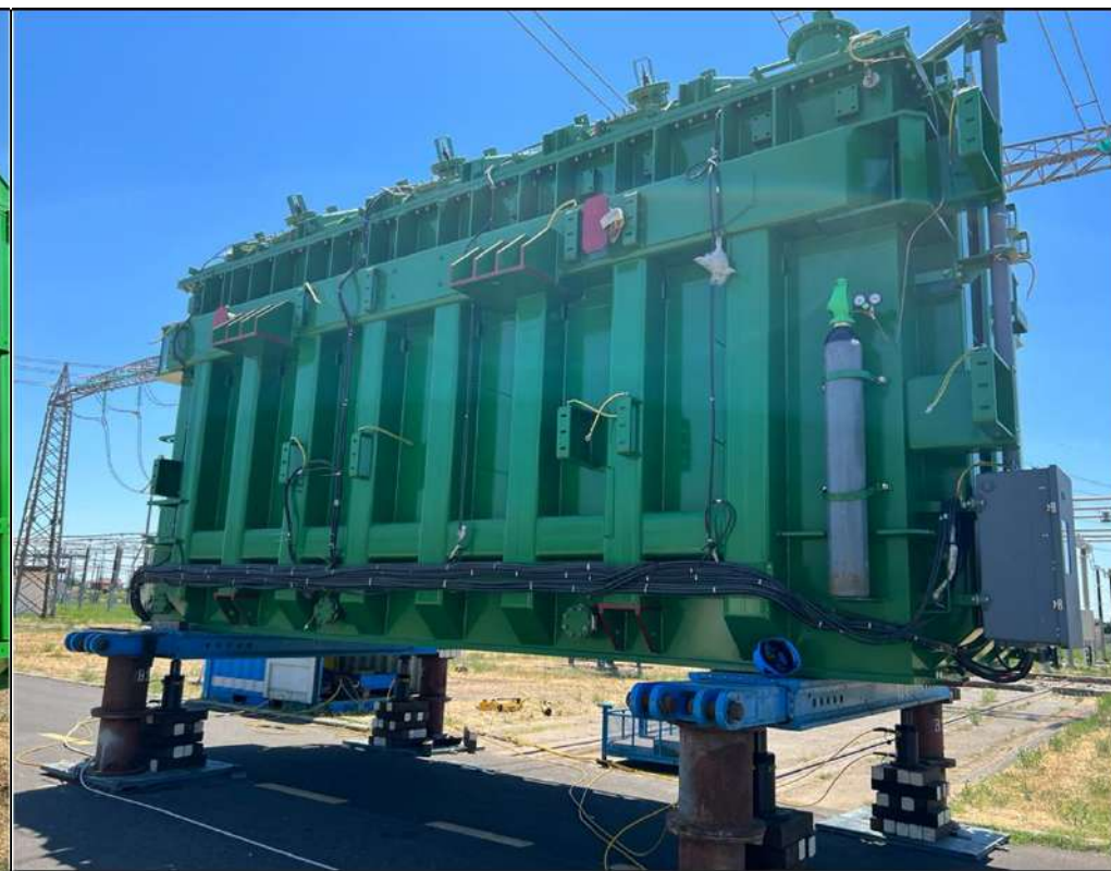
Scarico con Jack and Skidding
