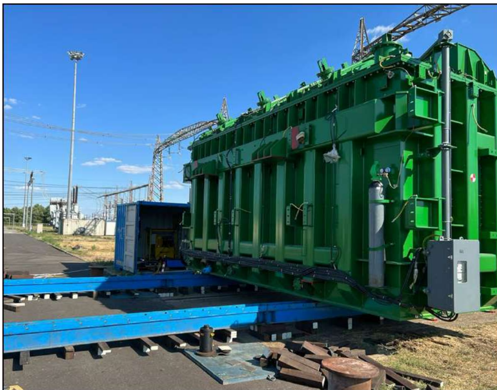
Scarico con Jack and Skidding
