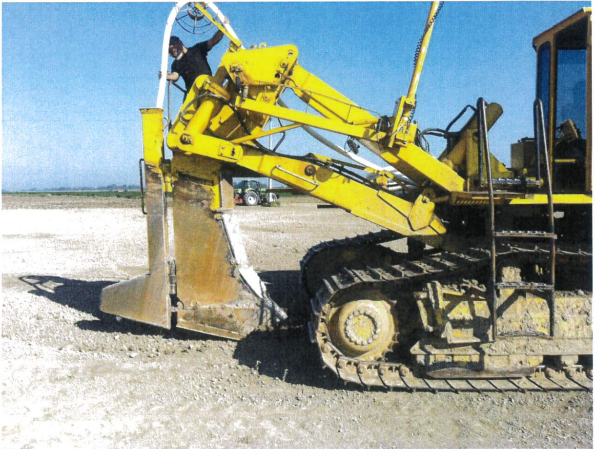
Figura 3-4 Posa del dreno
