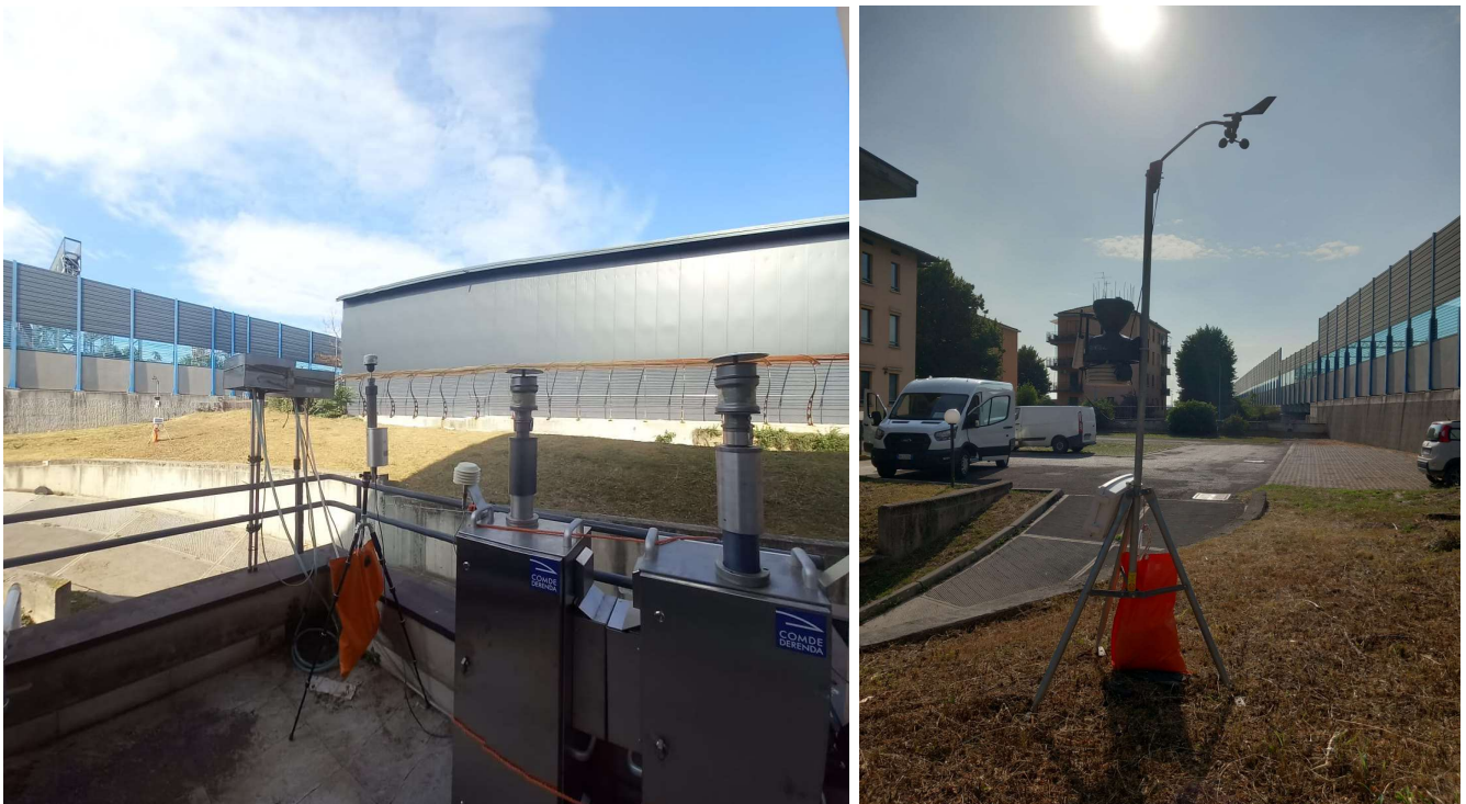
Figura 5 Strumentazione installata presso ATM02
