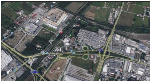
SITO IDR 04 AEREA
