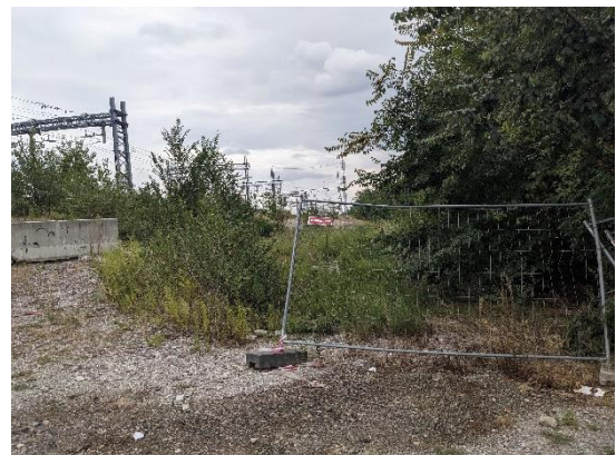
Veduta area cantiere
