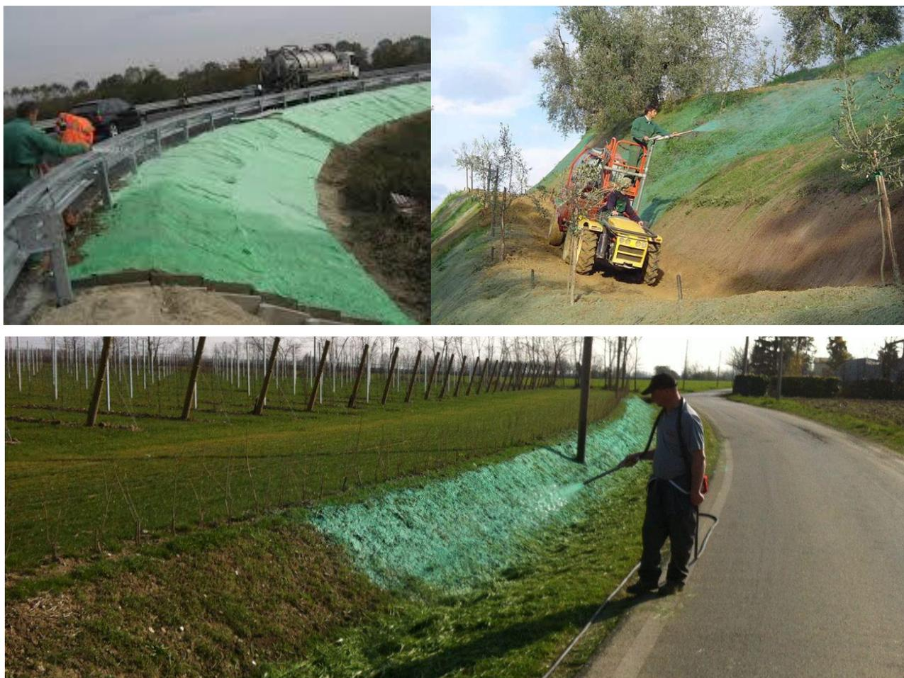
**Figura 35 – Tecniche di idrosemina**
