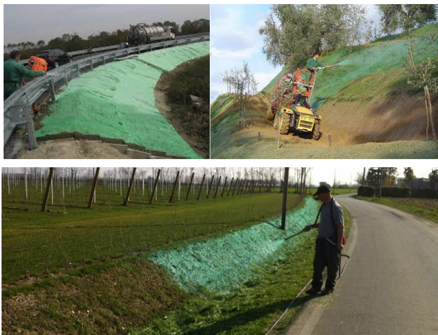
Figura 28 - Tecniche di idrosemina
