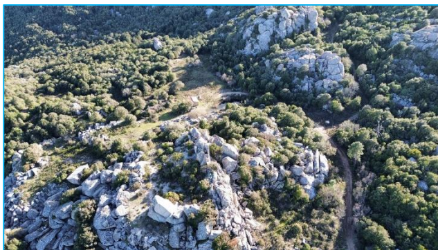
Documentazione fotografica dall' aerogeneratore SG04
