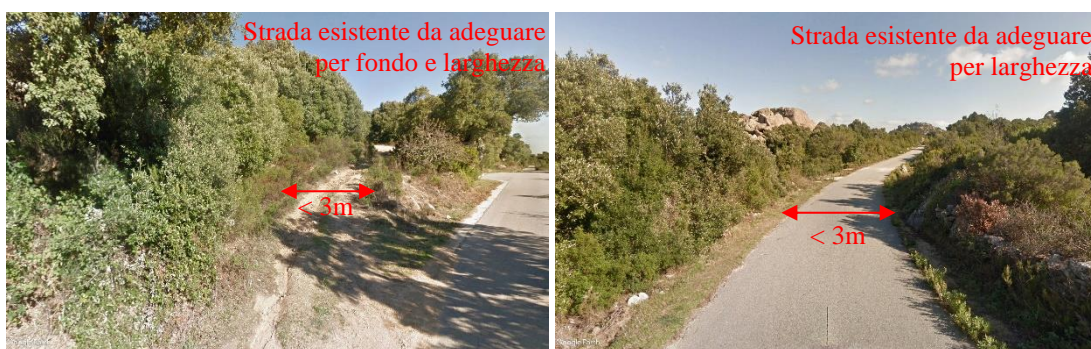
Figura 23 - Viabilità esistente, da adeguare per essere percorsa dai mezzi
