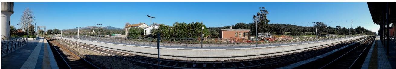
Stato di fatto del F9
