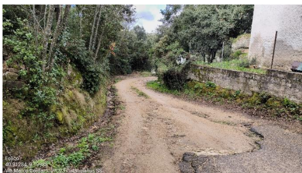
Figura 70 - Calangianus: l'area interessata dal terzo tratto di cavidotto all'interno del centro abitato
