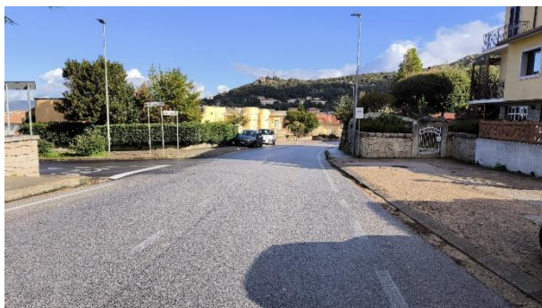
Figura 69 - Calangianus: l'area interessata dal terzo tratto di cavidotto all'interno del centro abitato
