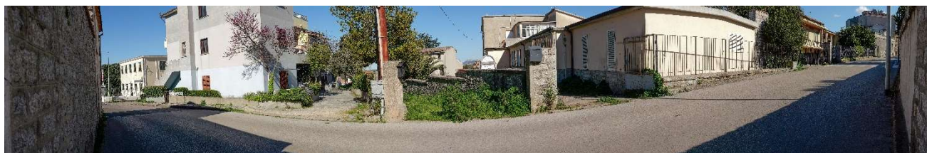
Figura 138 - Stato di fatto del punto di scatto F44
