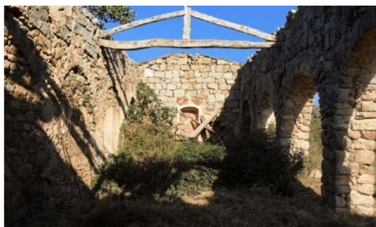
Figura 49 – Chiesa di San Pietro di Sionis – Luras
