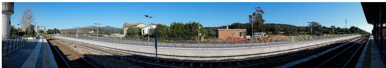
Figura 159 - Stato di fatto del punto di scatto F9
