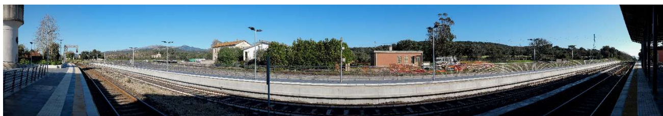
Figura 160 - Foto Post Operam del punto di scatto F9
