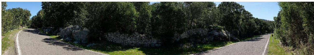
Figura 96 - Stato di fatto del punto di scatto F22
