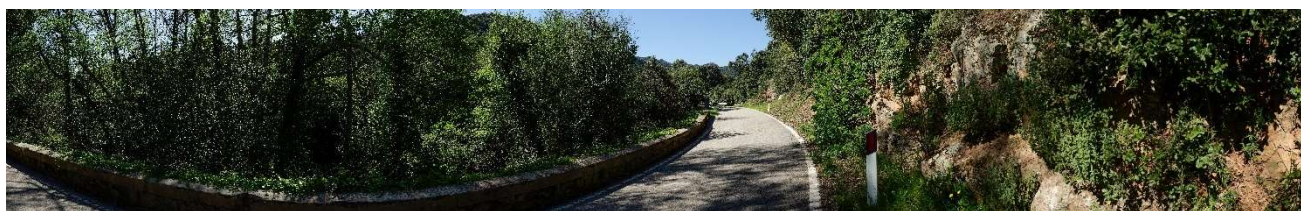
Figura 128 - Stato di fatto del punto di scatto F38
