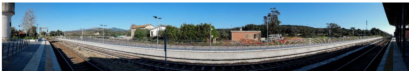
Figura 84 - Stato di fatto del punto di scatto F9
