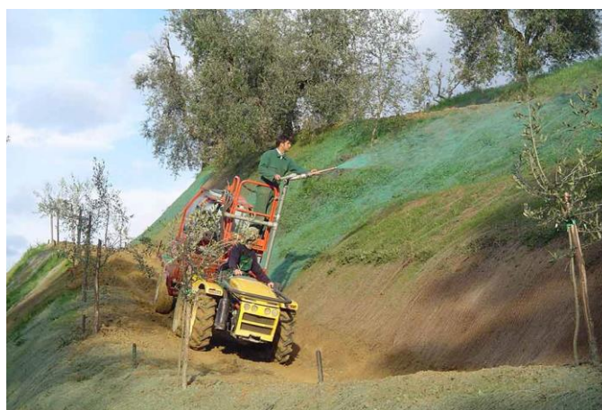
Figura 72 - Tecniche di Idrosemia
