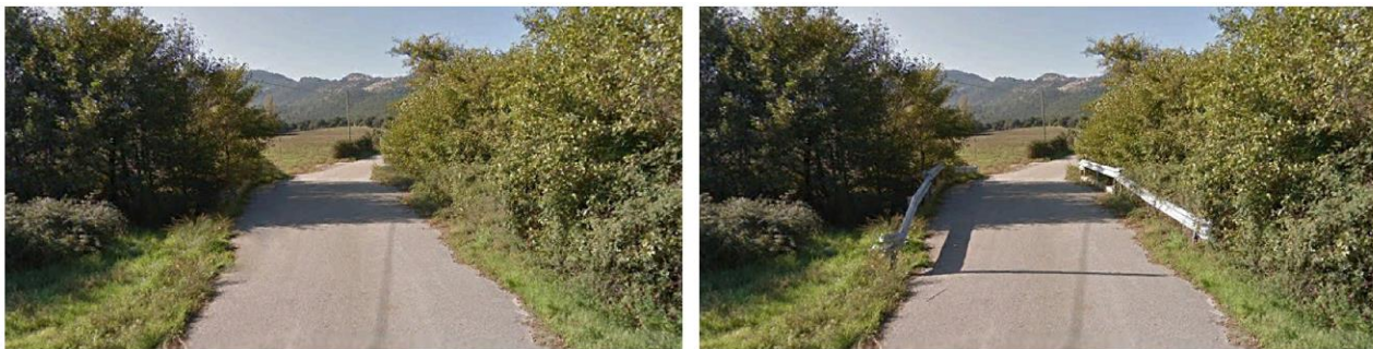
Figura 29 - smontaggio e il rimontaggio della recinzione o Guard rail
