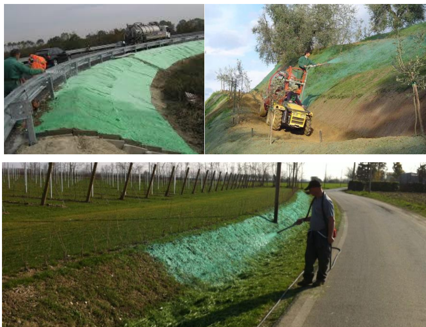
Figura 32 - Tecniche di idrosemina
