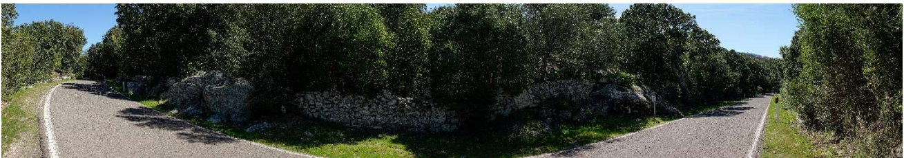
Figura 12 - Stato di fatto del punto di scatto F22
