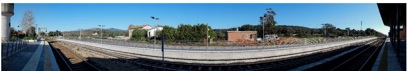
Figura 6 - Stato di fatto del punto di scatto F9
