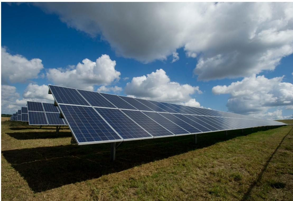
L'impianto fotovoltaico è costituito da strutture fisse disposte lungo l'asse est – ovest con inclinazione verso sud rispetto al piano campagna di 15°.
