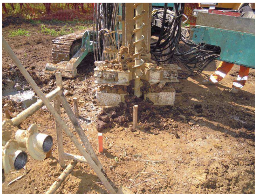
Macchina operatrice per la realizzazione di micropali tubfix; sistema di scavo mediante trivella elicoidale
