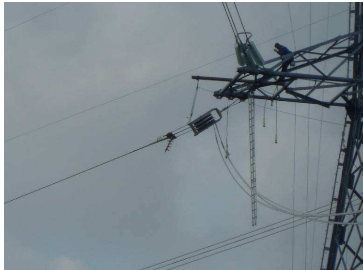
Fasi di tesatura della linea elettrica
