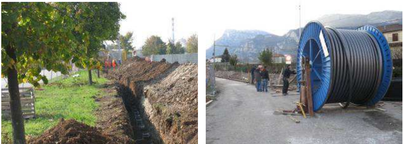
Posa rulli lungo lo scavo e stendimento del cavo
