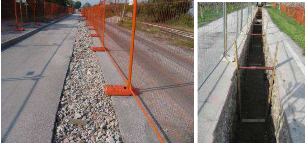
Taglio dell'asfaltatura e scavo aperto
