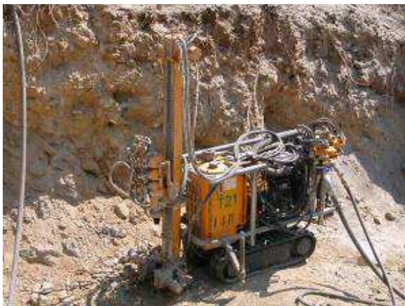
Esempio di fondazione con tiranti in roccia
