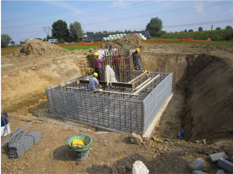
Realizzazione di fondazione superficiale tipo plinto a monoblocco per un sostegno monostelo. Nell'immagine si può osservare la fase di cassetatura
