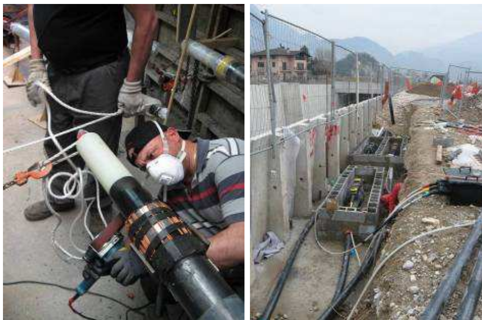
Esecuzione giunto esempio di buca giunti
