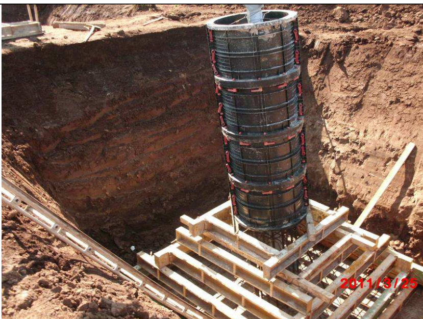
Esempio di realizzazione di una fondazione a plinto con riseghe. Nell'immagine di sinistra si può osservare un disegno di progetto mentre nell'immagine di destra la fase di cassetatura della fondazione
