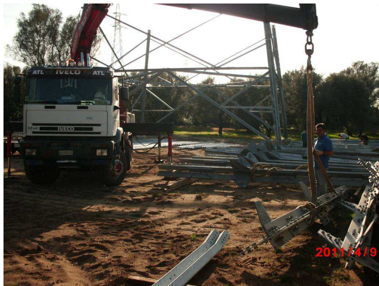
Fasi di montaggio sostegno a traliccio
