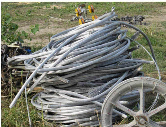
Fasi demolizione di un sostegno a traliccio
