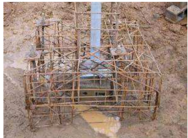
Esempio di fondazione con tiranti in roccia
