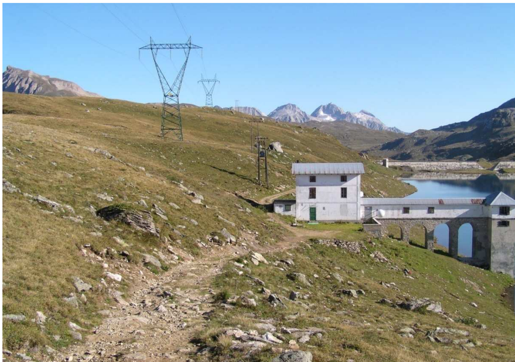
Vista dal lago Castel verso nord della linea attualmente esistente (dal Lago Castel al sostegno n.19 l'alternativa segue la vecchia linea esistente)
