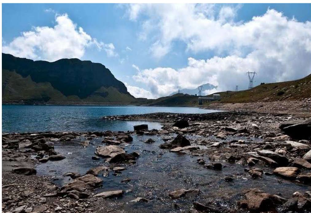
Vista dal lago Castel verso sud della linea attualmente esistente (dal Lago Castel al sostegno n.19 l'alternativa segue la vecchia linea esistente)
