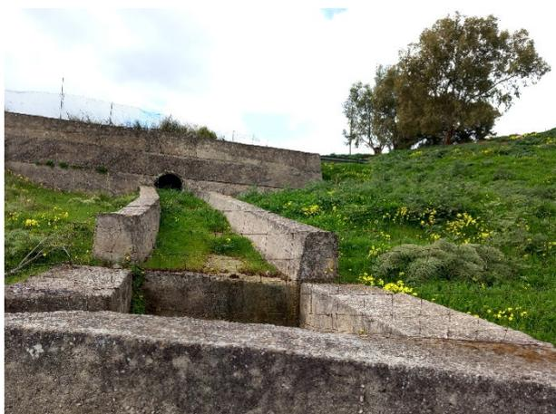
3. la terza interferenza è caratterizzata dalla presenza di un fosso interessato da un corso idrico secondario superato con un manufatto idrico in CLS armato, riscontrato in cartografia, come si evince dalle foto sotto riportate:
