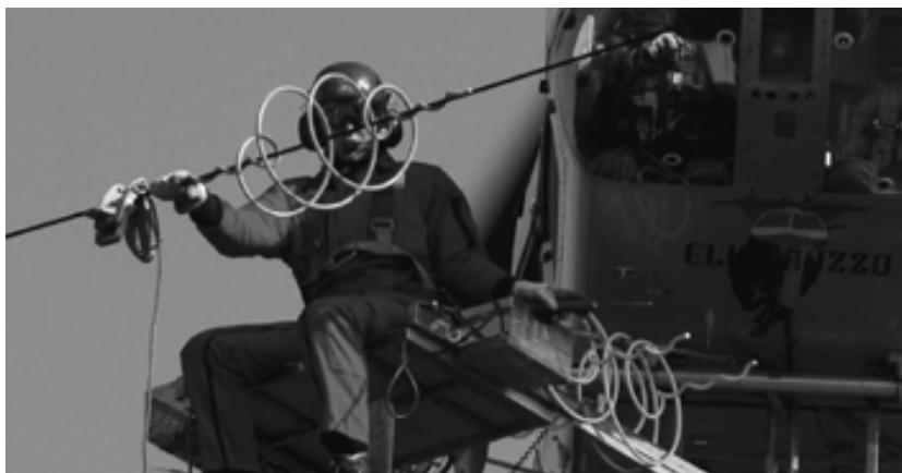
Installazione segnalatori ottici e ad acustici (spirali colorate in plastica).
