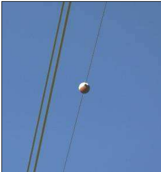
Sfera di poliuretano colorata su cavo aereo
