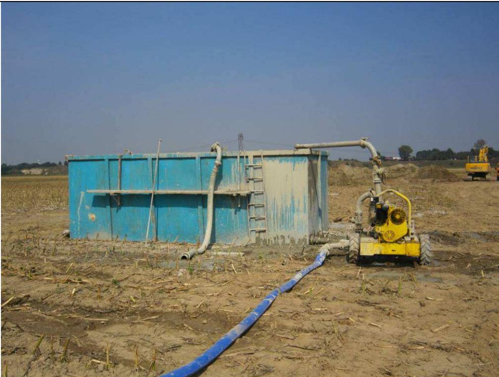
Allestimento di un impianto a circuito chiuso per la realizzazione di pali trivellati mediante l'utilizzo di fanghi bentonitici. In questa immagine si osservano la vasca prefabbricata per la decantazione del fango e la pompa di rilancio del fango verso il foro
