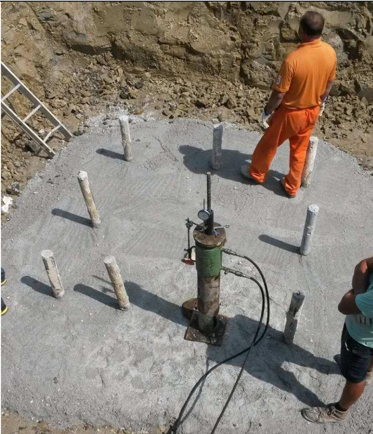
Realizzazione di micropali tipo tubfix per un sostegno a traliccio; si possono osservare i 9 micropali già realizzati ed iniettati; in questa fase, prima dell'armatura e cassetatura del plinto di fondazione, si sta eseguendo una prova di tenuta del micropalo allo strappamento, al fine di verificare la corretta progettazione e realizzazione dello stesso
