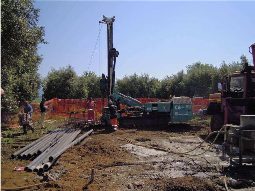
Cantiere per la realizzazione di micropali tipo tubfix; si può osservare sulla sinistra la zona di deposito dei tubolari metallici i quali costituiranno l'armatura dei micropali e sulla destra il miscelatore per la preparazione della boiaccia di cemento per l'iniezione a gravità dei micropali
