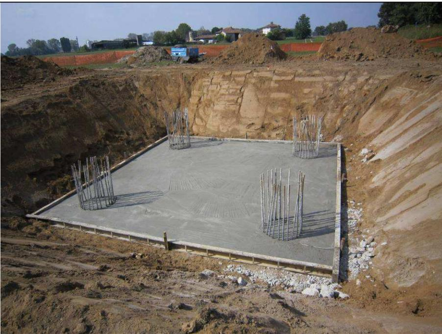
Realizzazione di una fondazione su pali trivellati per un sostegno monostelo. Nell'immagine si può osservare una fondazione in fase di realizzazione. Si possono distinguere facilmente i quattro pali trivellati già realizzati e gettati (si osservano le "ripresе" delle quattro gabbie metalliche) ed il piano di "magrone" sul quale impostare il monoblocco in cls
