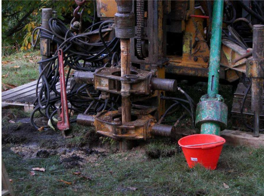
*Macchina operatrice per la realizzazione di micropali tubfix; sistema di scavo a rotoperussione*
