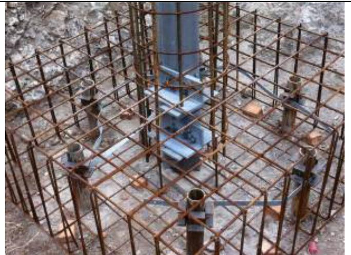
Esempio di realizzazione di una fondazione su micropali tipo tubfix. Nell'immagine di destra si può notare il particolare del raccordo tra i tubolari metallici dei micropali con l'armatura del plinto di fondazione; al centro del plinto si nota il moncone del sostegno (elemento di raccordo tra il sostegno e la fondazione) il quale viene annegato nella fondazione stessa
