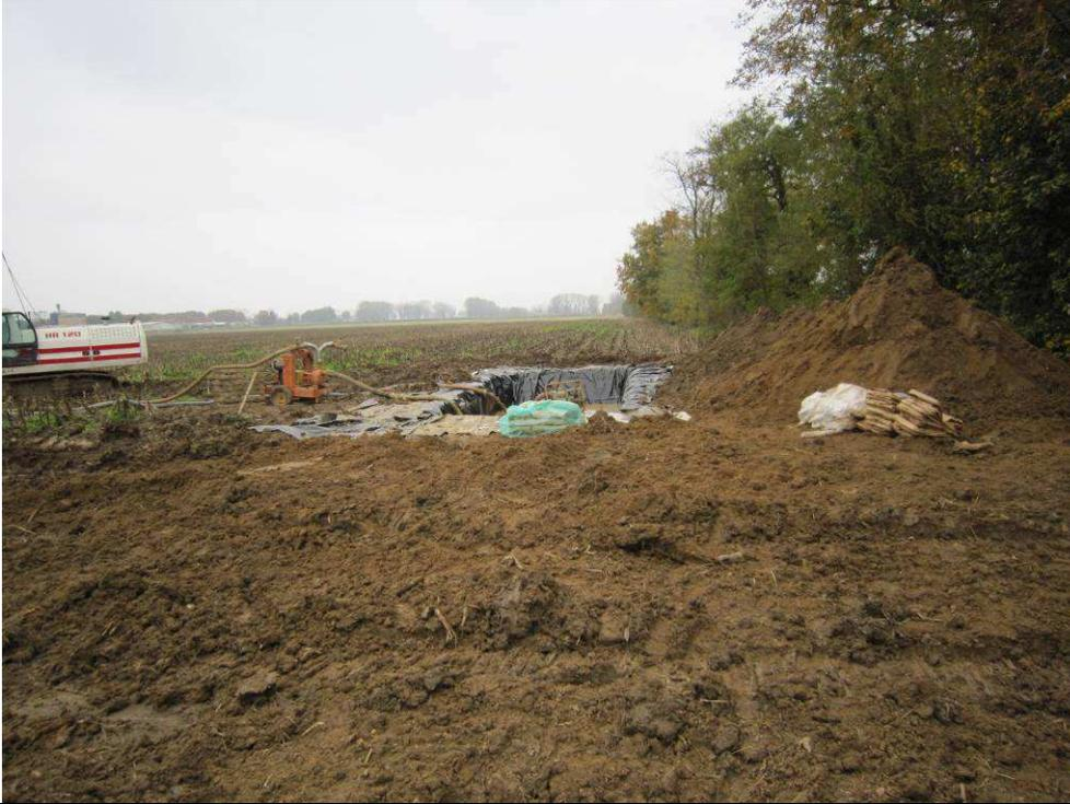
Allestimento di un impianto a circuito chiuso per la realizzazione di pali trivellati mediante l'utilizzo di fanghi bentonitici. In questa immagine si osservano la vasca impermeabilizzata per la decantazione del fango, la pompa di rilancio del fango verso il foro e l'area di deposito dei sacchi contenenti la bentonite
