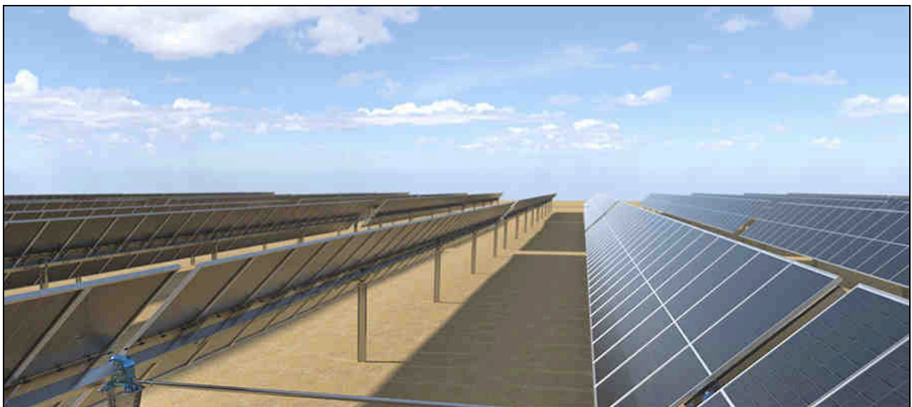
Rappresentazione indicativa struttura sostegno e moduli fotovoltaici
