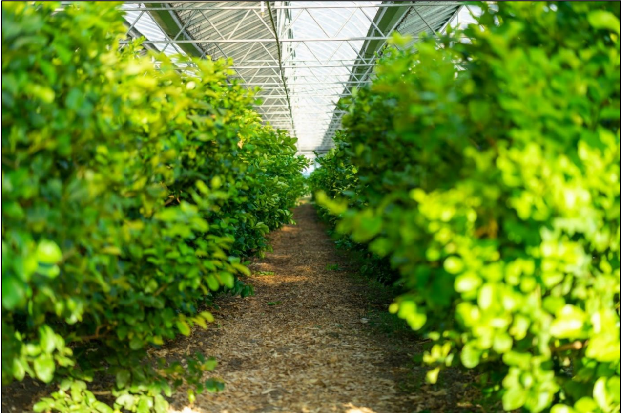
Foto 1: Serra fotovoltaica con coltivazione di limoni
