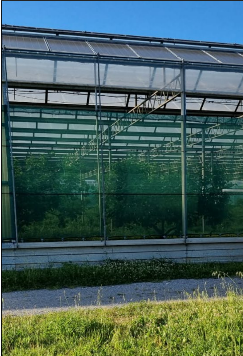
Foto 3: Foto 3: Serre agrivoltaiche dell'impianto di Scalea (CS), all'interno delle quali si coltivano agrumi (cedri e limoni). Si evidenzia la tipologia di rete frangivento che verrà utilizzata per i tracker dell'impianto agrivoltaico di San Biagio
