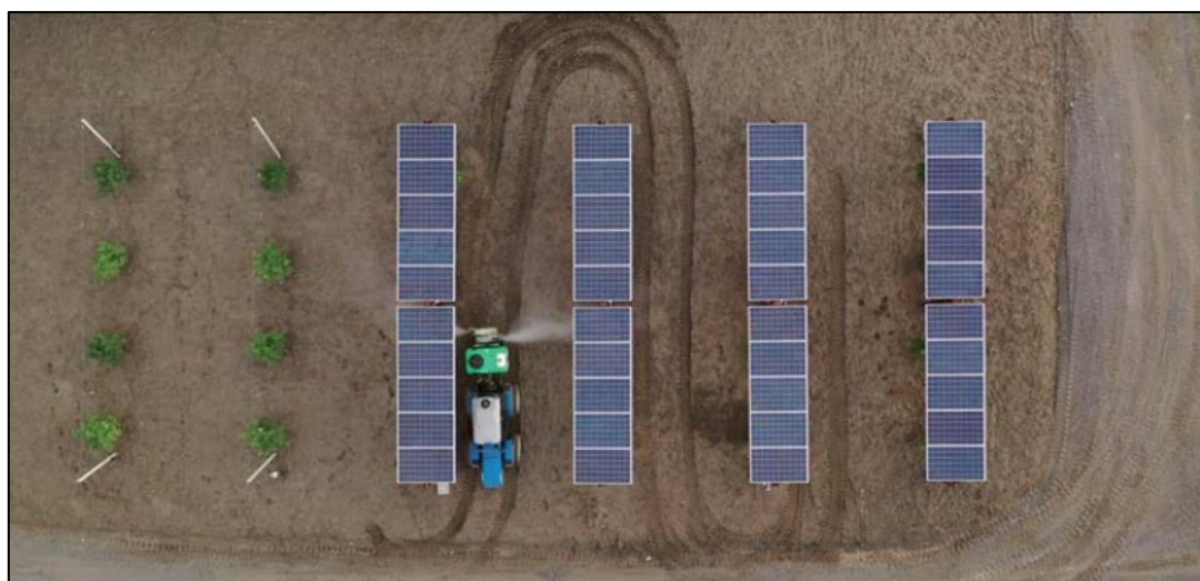
Foto 4: Impianto dimostrativo realizzato nel complesso agrivoltaico di Scalea (CS).
