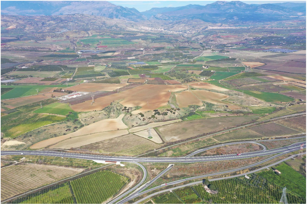
Figura 22: Cono di ripresa 1a - Area Intervento Ante Operam
