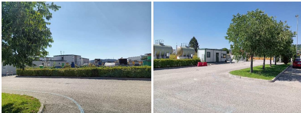
Figura 3.5-7 Aree interne al cantiere
