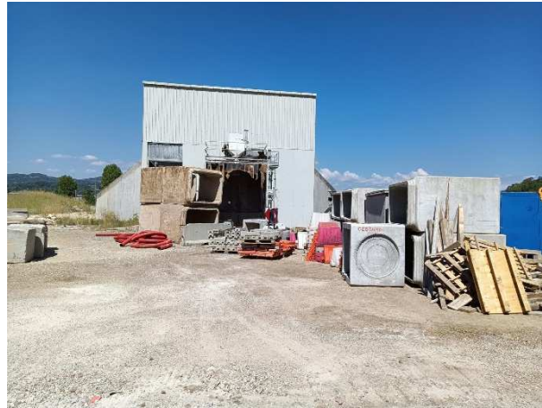
Figura 3.5-9 Piazzale e impianto di calcestruzzo
