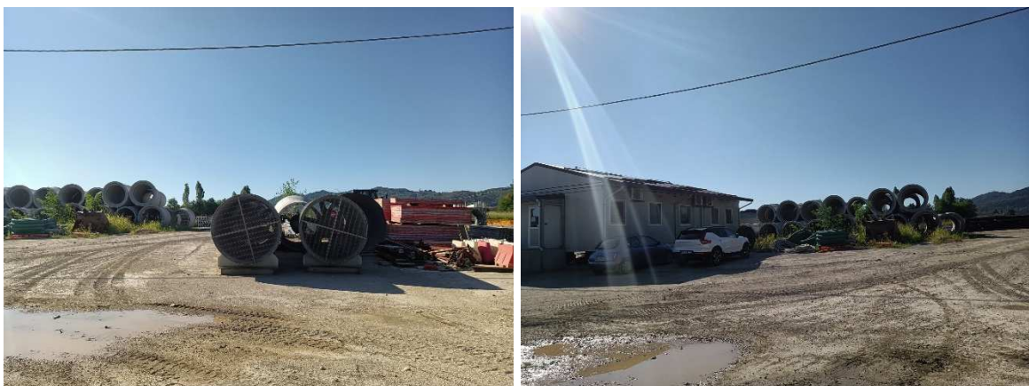
Figura 3.5-2 Deposito terre, materiali e mezzi per attività di cantiere
