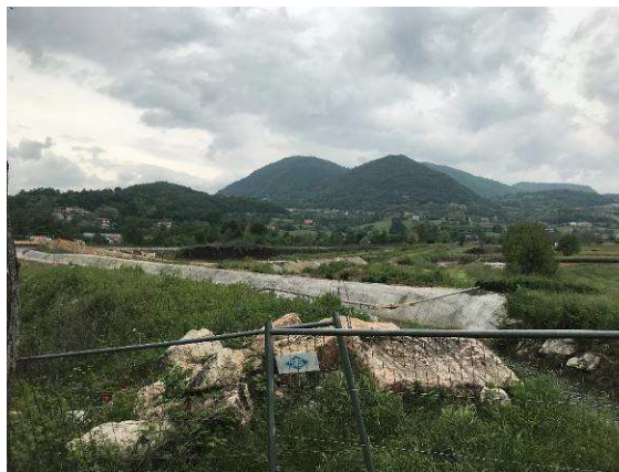
Figura 3.9-1 PASF_11 - Deviazione temporanea del Torrente Poscola CO2019
