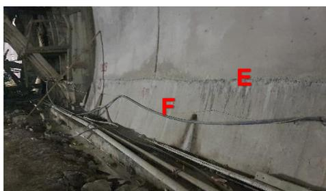
Particolare del punto in cui fuoriesce l'acqua raccolta dal tubo di drenaggio (F). Sullo sfondo è visibile il cassero mobile che viene utilizzato per il getto del rivestimento definitivo della calotta
