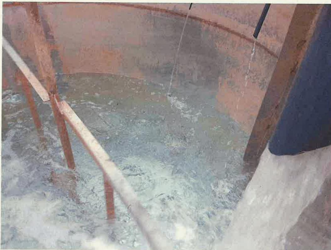
**Foto 3:** acque dreni sollevate a vasca dosaggio reagenti (correzione pH con HCl)
