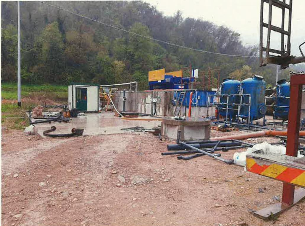
Foto 1: Impianto di trattamento per acque dreni da microtunnel della Galleria Malo
