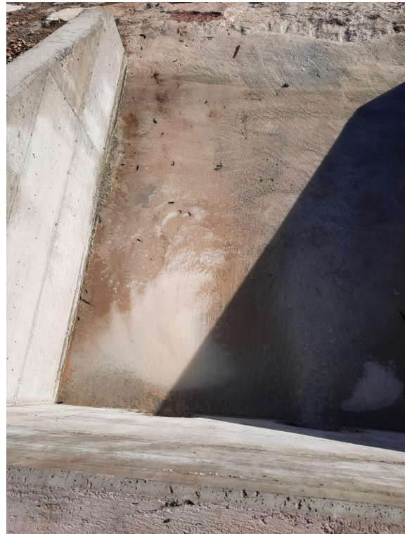
Figura 3: Scarico microtunnel - Vista dall'alto (27/03/2023)
