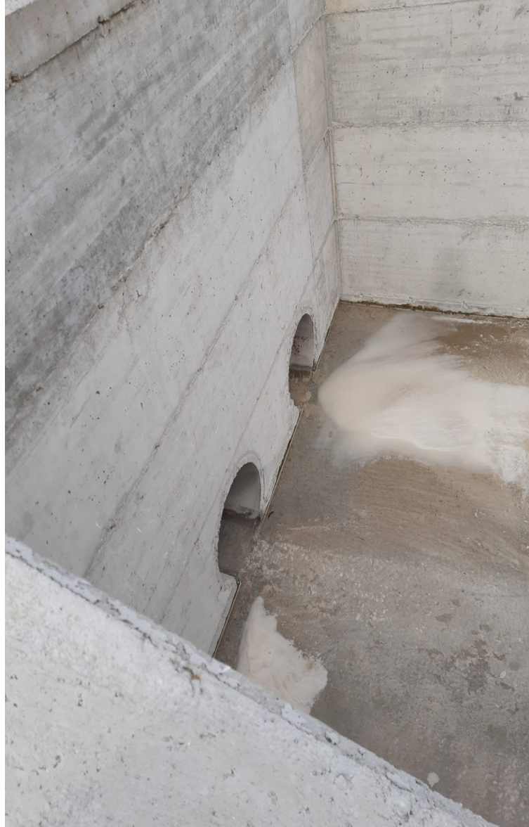
Foto 1: Punto di scarico su torrente Orolo
