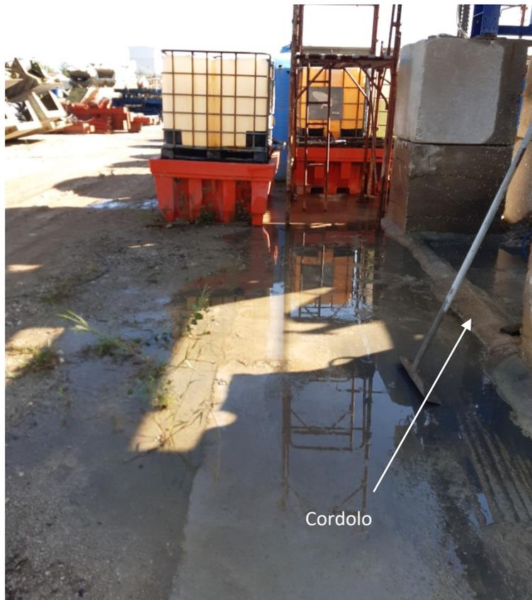
Foto 5. Dispersioni di acqua derivante dalla filtropressa su pavimentazione in cemento oltre il cordolo e anche su pavimentazione in stabilizzato, riscontrata nella mattinata del 19/09/2023
