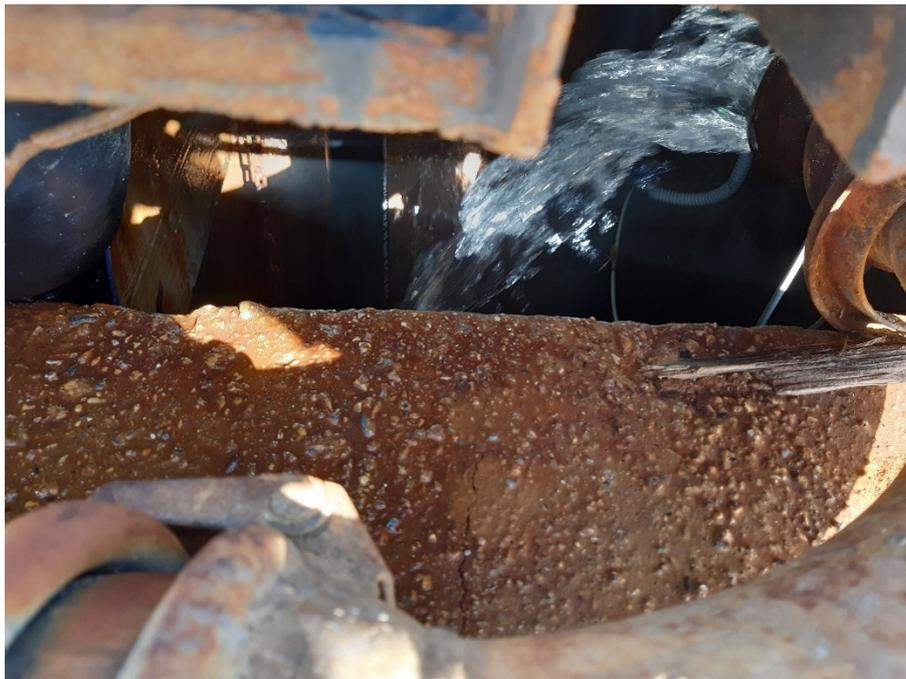
Foto 2. Dettaglio dell'immissione nella vasca di ingresso dei tubi di "troppo pieno" della vasca di omogeneizzazione e della vasca di accumulo. Vi era fuoriuscita d'acqua solo dal tubo relativo alla vasca di accumulo per rilancio ai filtri.
