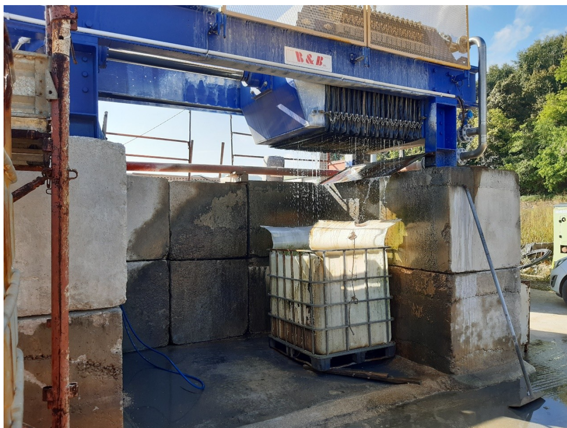
Foto 4. Retro della sezione di filtrazione, con evidenza dell'uscita di parte dell'acqua per gravità e raccolta della stessa su tank aperto sulla sommità
