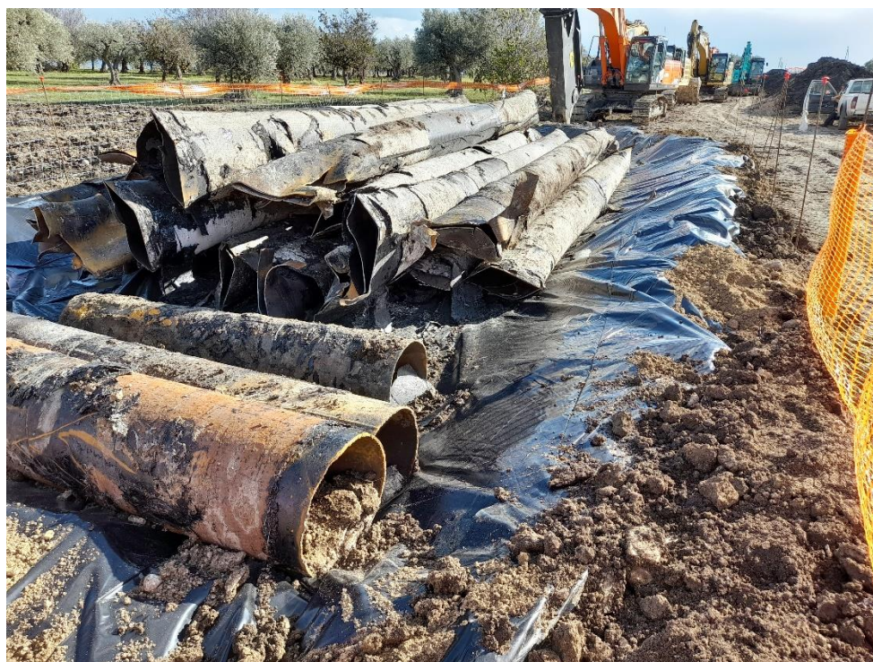
Figura 22 – Modalità di preparazione del deposito temporaneo per l'accastamento delle tubazioni rimosse
