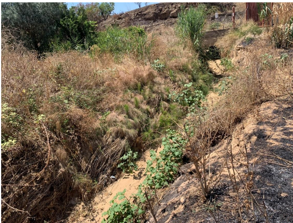
Figura 10 Canale scorrimento acque Lotto 3 Est
