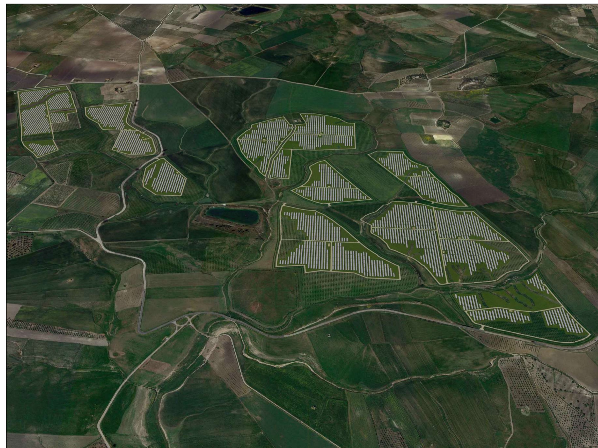
LOTTO FONTANAZZA _ VISTA DA EST
