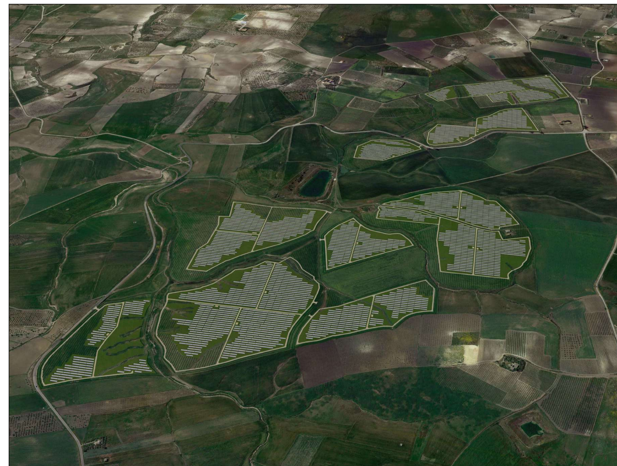
LOTTO FONTANAZZA _ VISTA DA NORD
