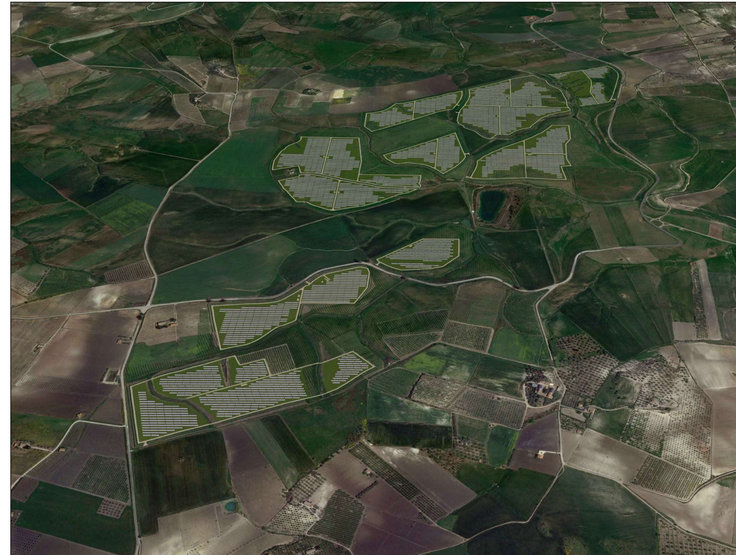
LOTTO FONTANAZZA _ VISTA DA SUD
