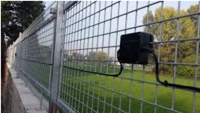
Figura 6 - Tipologico di cavo microfonico
