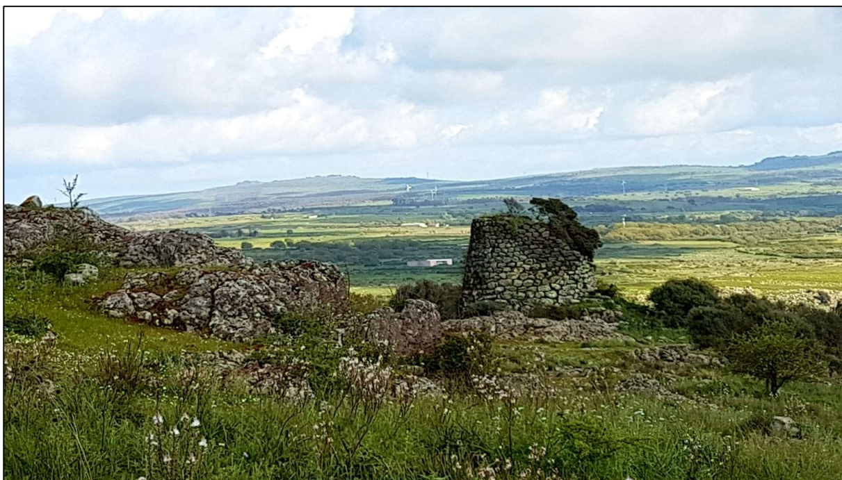
Figura 3. Nuraghe Ala, sullo sfondo si intravedono le pale eoliche già installate sul territorio.
