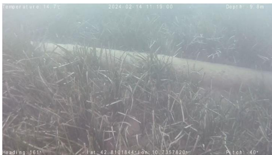
Figura 5-7 Estratto Transetto 2: Tubazione sul fondale per lo scarico del depuratore con Posidonia (fonte: figura 20 Oikos 2024)
