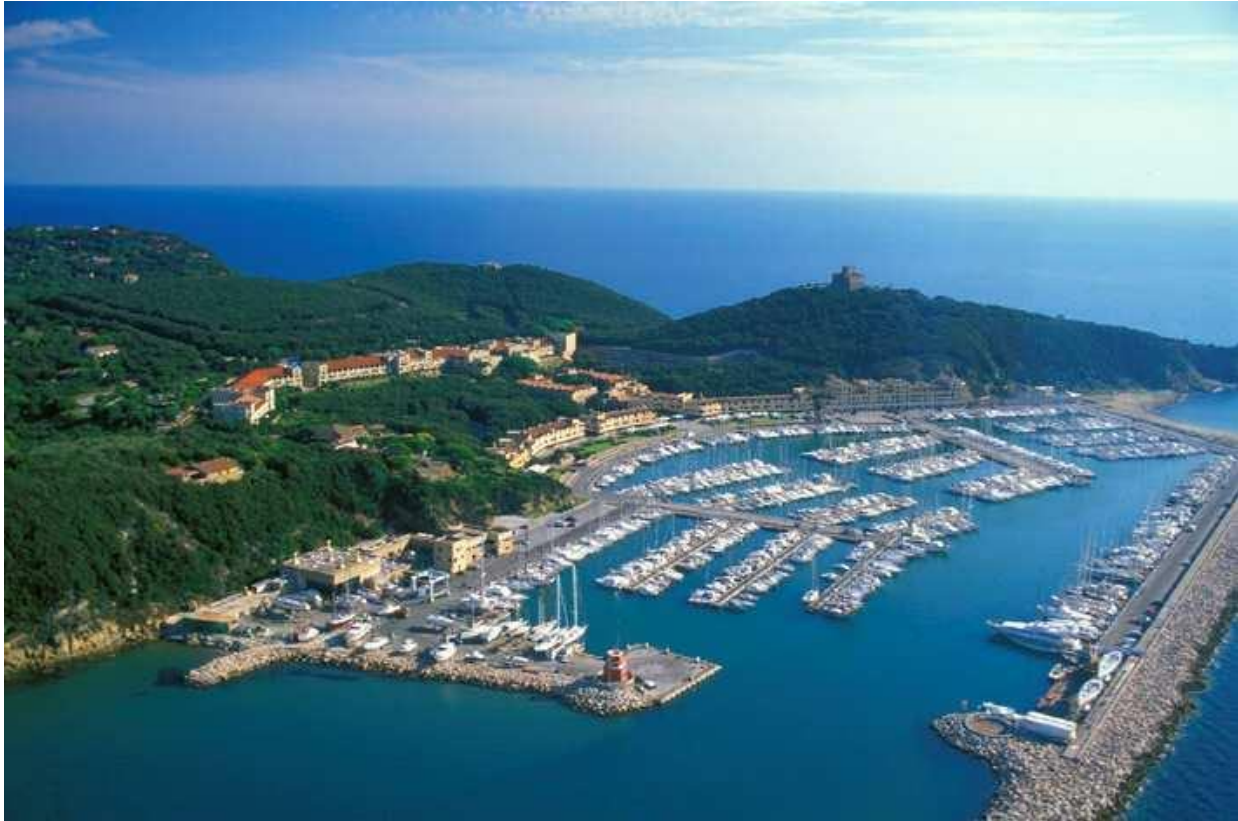
Figura 5-24 Vista aerea da sud del porto di Punta Ala
