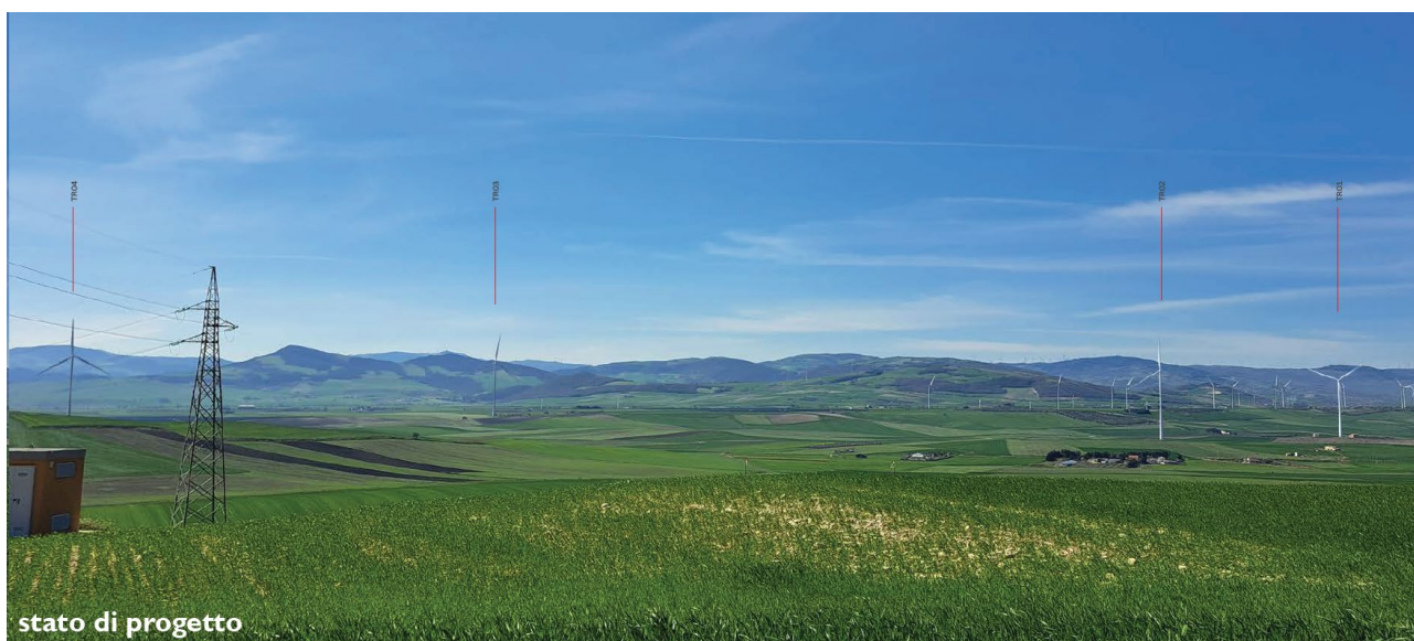
Regio Tratturello Foggia Troia Incoronata
