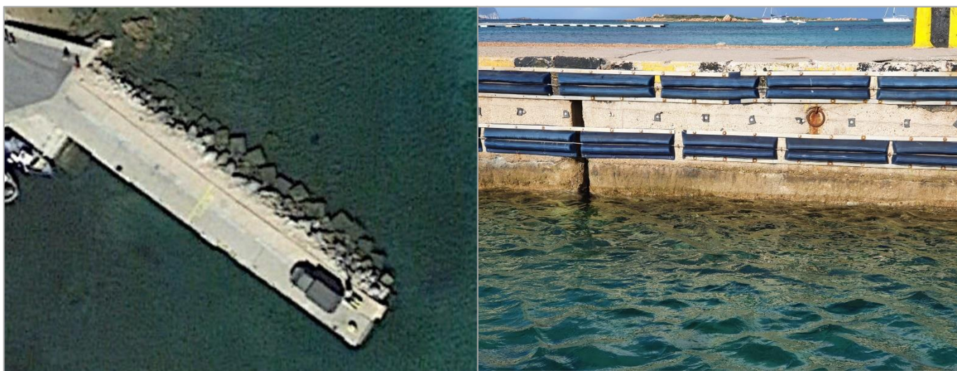
Figura 7 Foto dello stato attuale scogliera da rifiorire e giunto tipo da ripristinare
