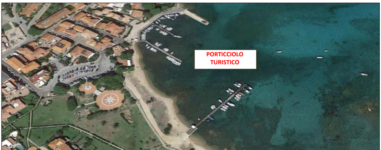
Figura 1.1-1.2: In alto panoramica generale e in basso panoramica di dettaglio dell'area del porticciolo oggetto di intervento
