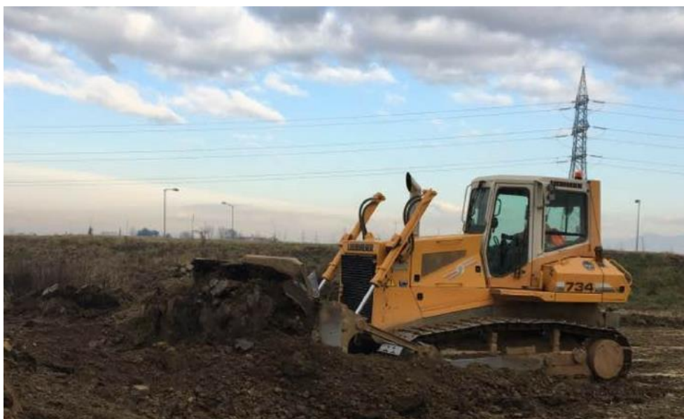
Figura 3.3: Esempio Attività di Scavo Materiale
