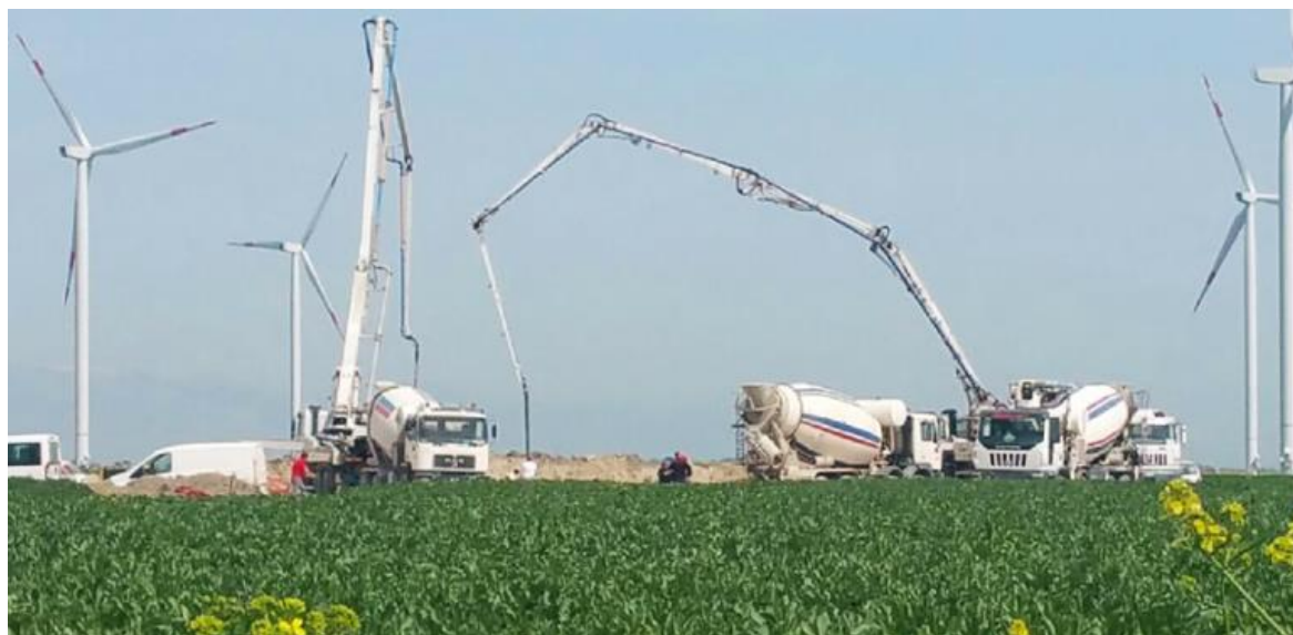
Figura 3.7: Esempio cantiere con mezzi
