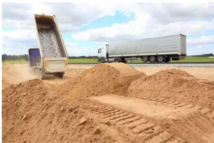
Figura 3.4: Esempio Attività di Formazione Cumuli di Stoccaggio
