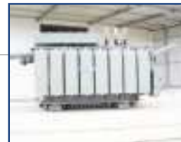
30 MVA 110/11,5 kV ONAN
