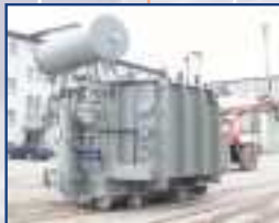
28 MVA 24/1,1 kV OFWF
