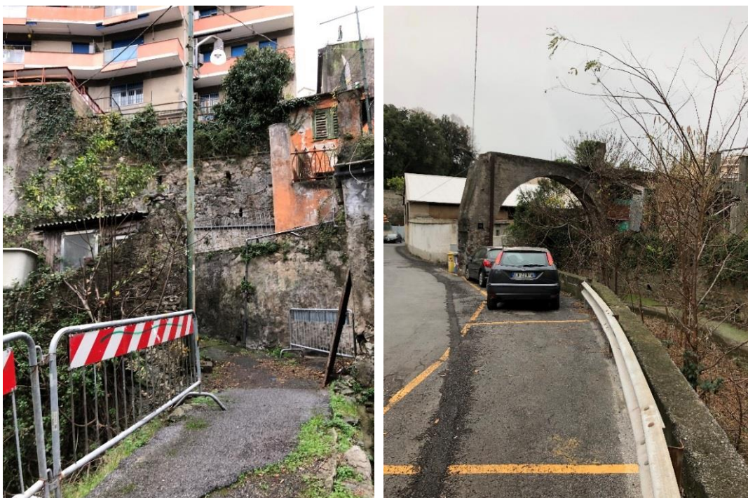
Figura 29: Rio Molinassi: stato di fatto – Attraversamento pedonale di via Negroponte (foto sinistra) e ponte canale in via L. Galvani (foto destra).
