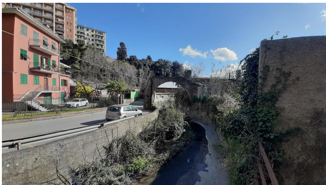
Figura 64: Vista verso valle da sez. 54.1 con presenza del ponte canale alla sez. 53
