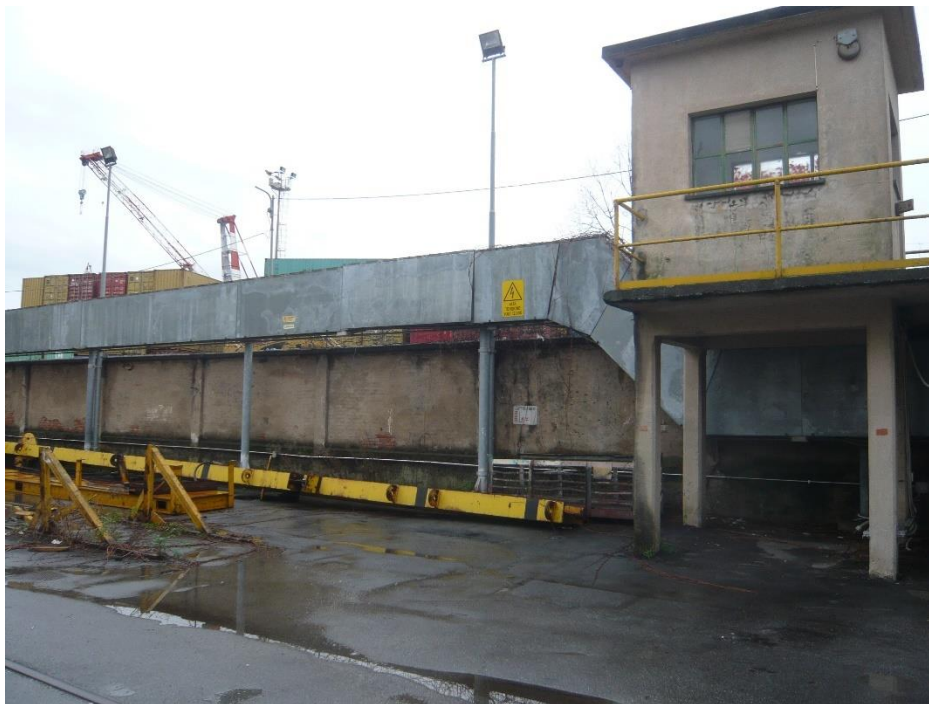
Figura 26 - cavo AT lungo il muro sud di Fincantieri al confine con via Bressanone
