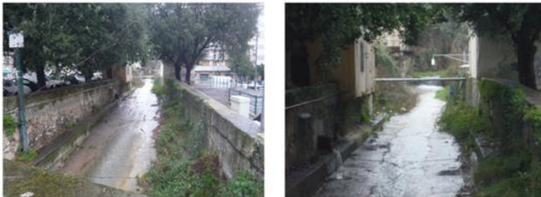
Figura 27: Tratto esistente a cielo aperto del Rio Molinassi a monte di Via Merano sotto il quale scorrono le 12 condotte degli oleodotti
