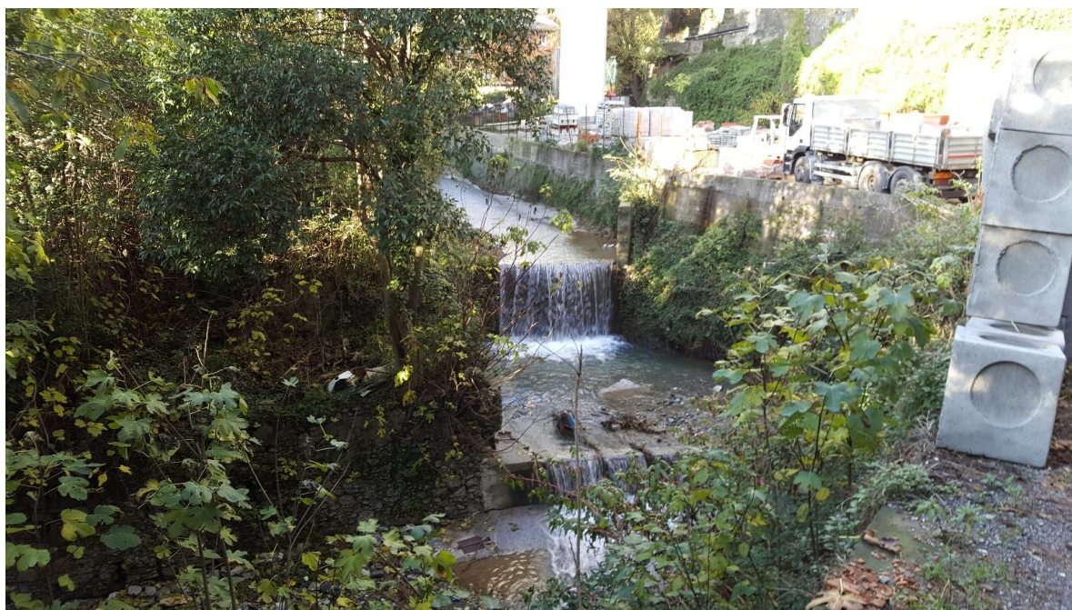
Figura 56: Salti di fondo esistenti dove sarà inserita la briglia Creager di monte
