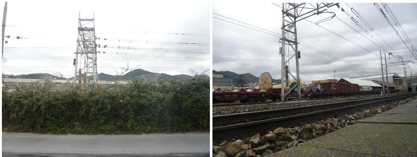
Figura 24: Tratta dei binari non interrompibili. A destra foto da sud verso nord e a sinistra foto da est verso ovest
