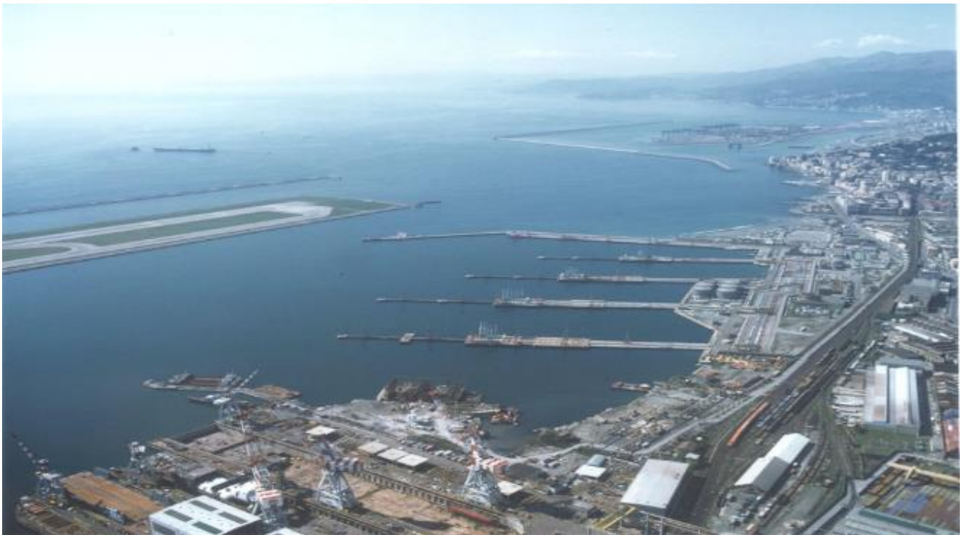
Figura 1 - Vista area dell'area di esecuzione della nuova calata a mare
