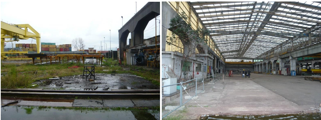
Figura 25: Area Fincantieri. A destra interno del capannone, sinistra area esterna (vista da nord verso sud)
