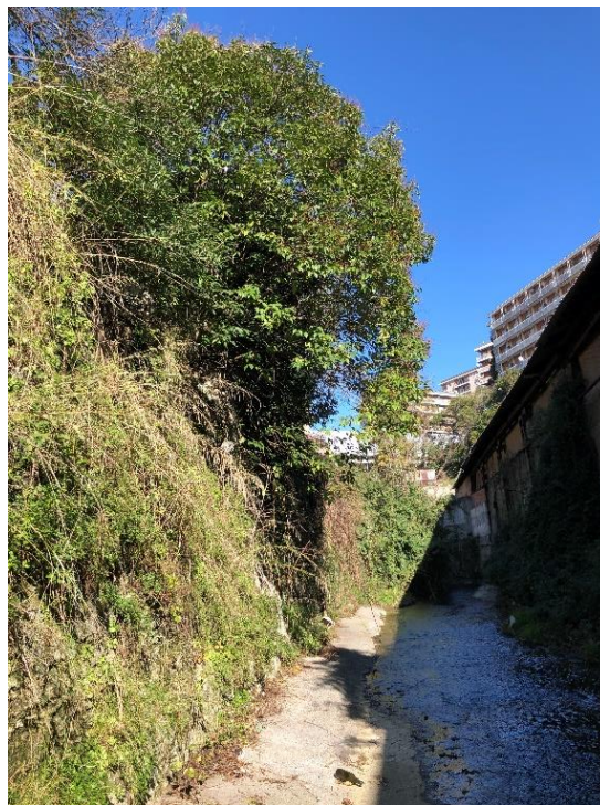
Figura 65: Vista verso monte da sez. 46 con edificio esistente in sponda destra
