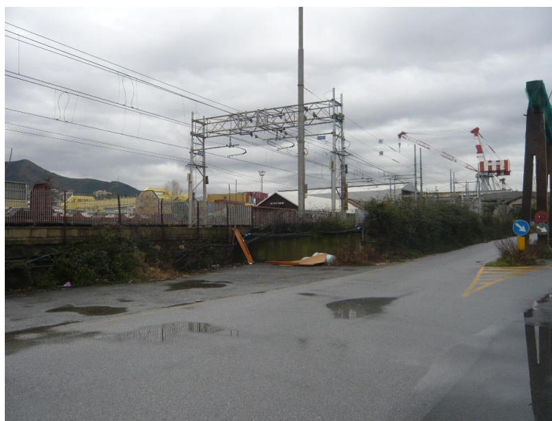
Figura 19: Attraversamento di via Ronchi (da ovest verso est)
