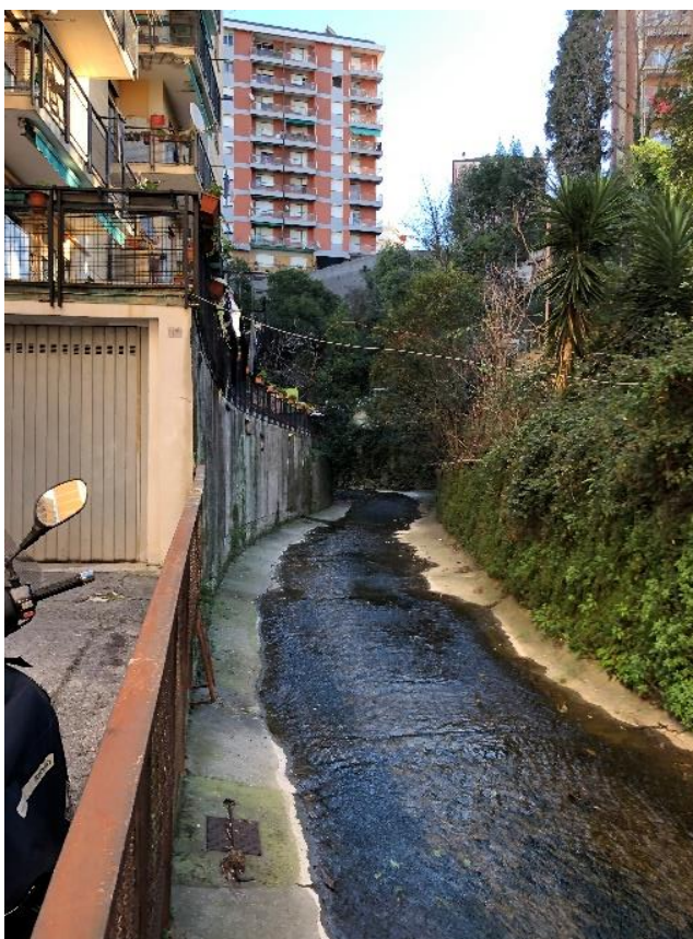
Figura 63: Vista verso monte da sez. 54.1
