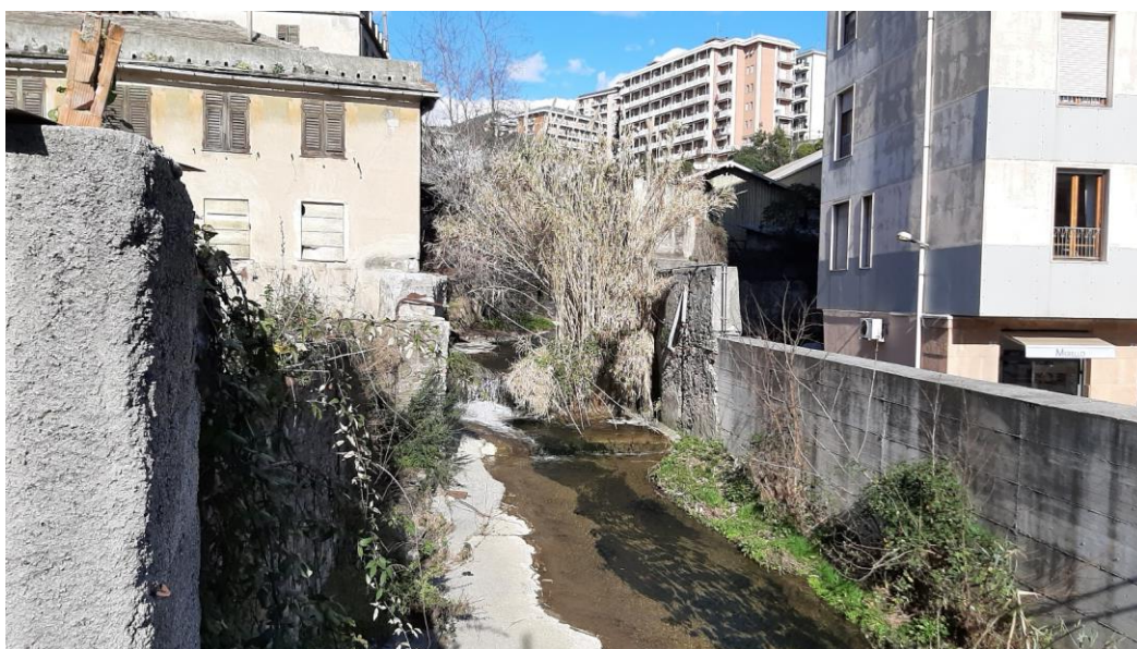
Figura 66: Vista verso monte da sez. 35 (salto di fondo esistente nelle sez. 37-38)
