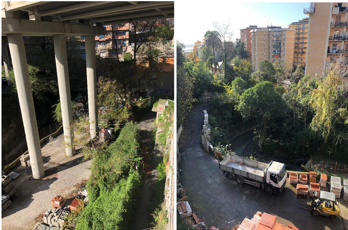
Figura 29: Magazzino edile sotto l'impalcato dell'A10
