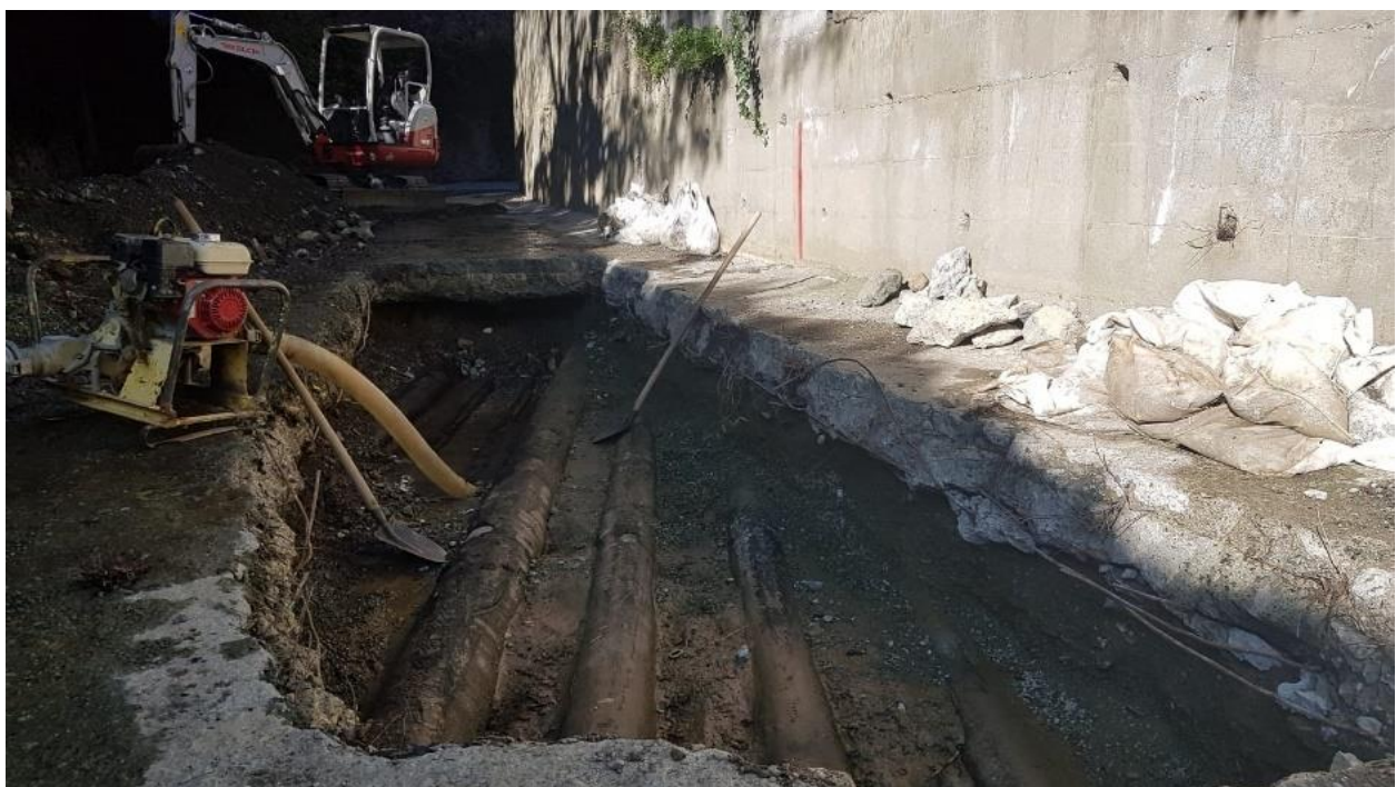
Figura 67 - Immagine dello scavo effettuato da Sigemi all'interno dell'attuale rio Molinassi in corrispondenza della futura briglia a funi
