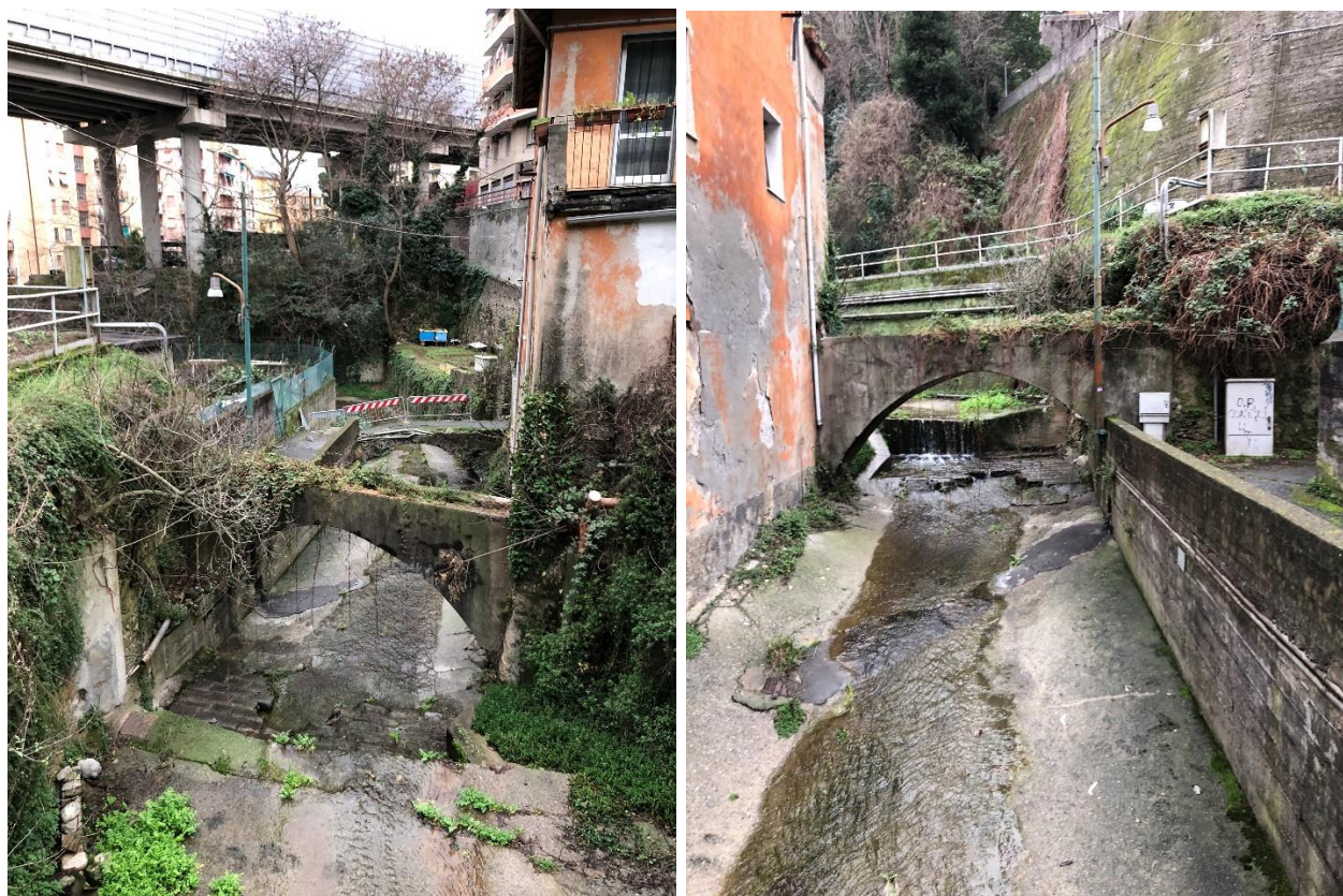
Figura 30: Area dove sarà realizzata la nuova briglia (edificio, ponte canale e passerella pedonale da demolire). A sx vista verso valle a destra vista verso monte.
