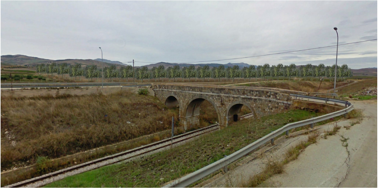
Figura 10 - Fotoinserimento A - stato POST operam impianto
