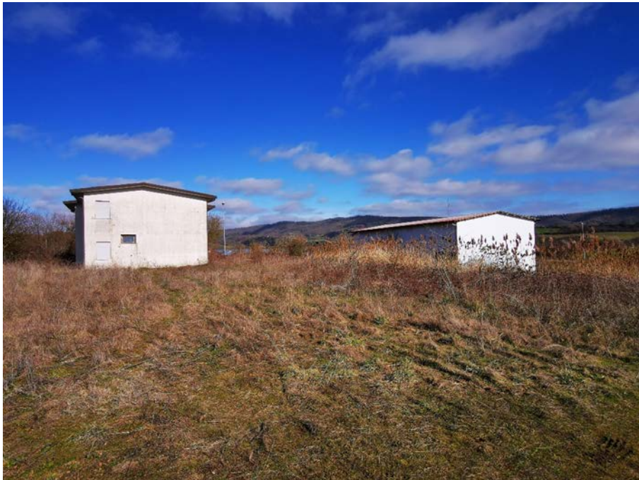
Figura 3.1.e Immagine dell'area ove è prevista la realizzazione delle opere in progetto: ex casa del custode (SX) e magazzino (DX)
