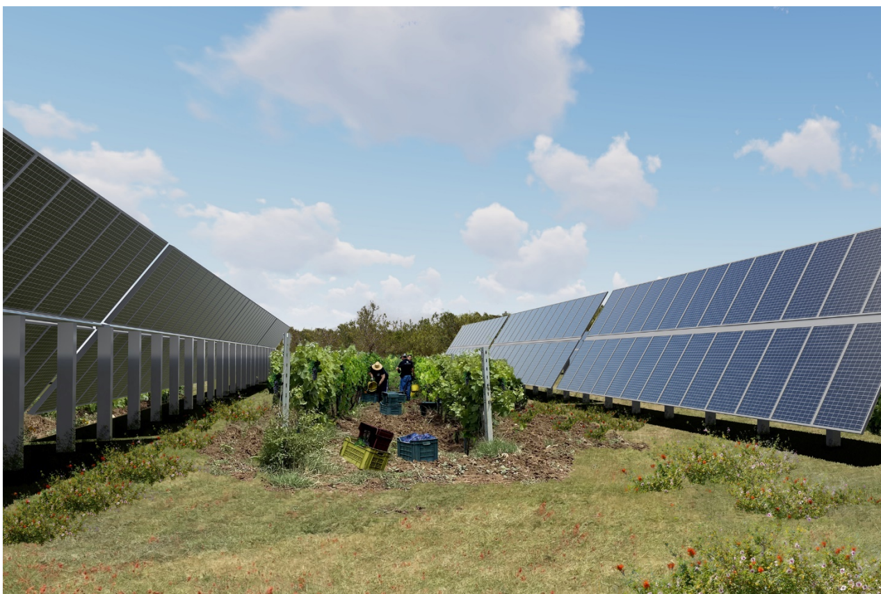
Fotoinserimento vista interna impianto
