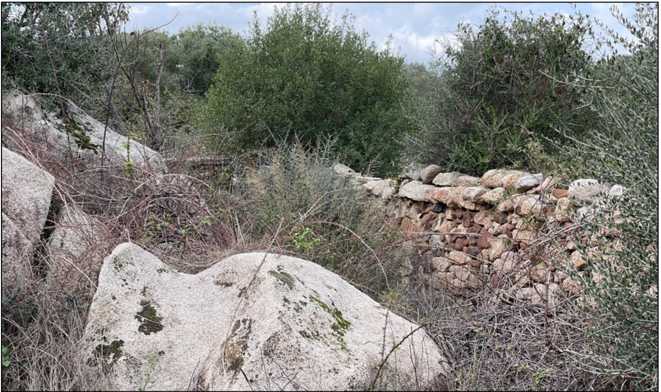
FIGURA 8 – Esempio di muro a secco con blocco lapideo di roccia effusiva in oliveto
