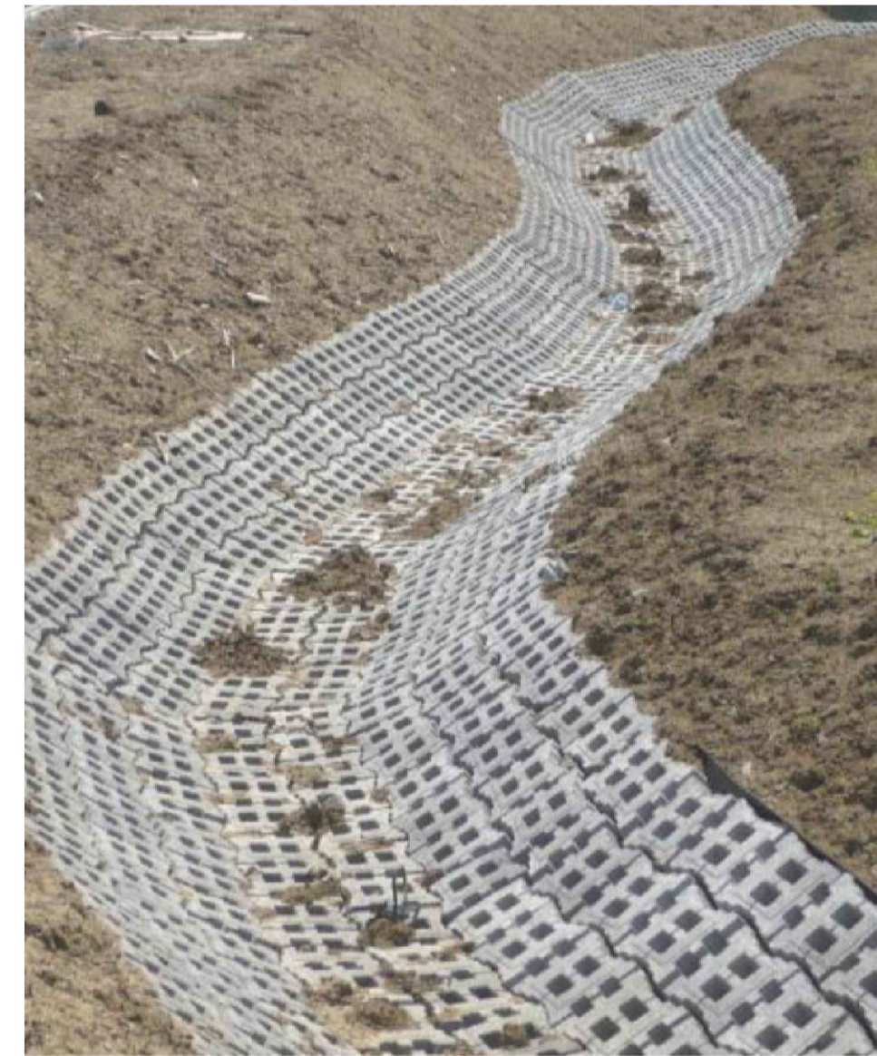
Pannello con blocchi del tipo aperto 20% di vuoto ed il tipo chiuso presenta dei fori con vuoti pari al 10 %
