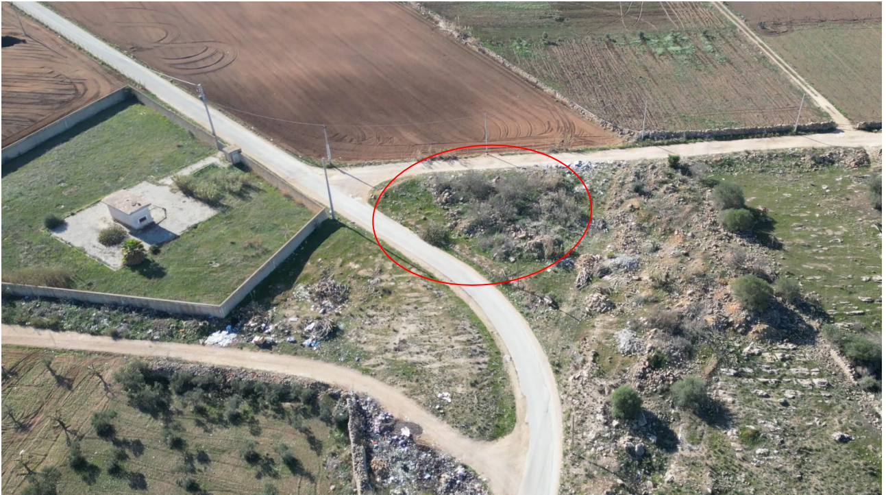
Foto aerea con indicata l'area in cui sarà realizzato il Manufatto di Consegna Petrosino
