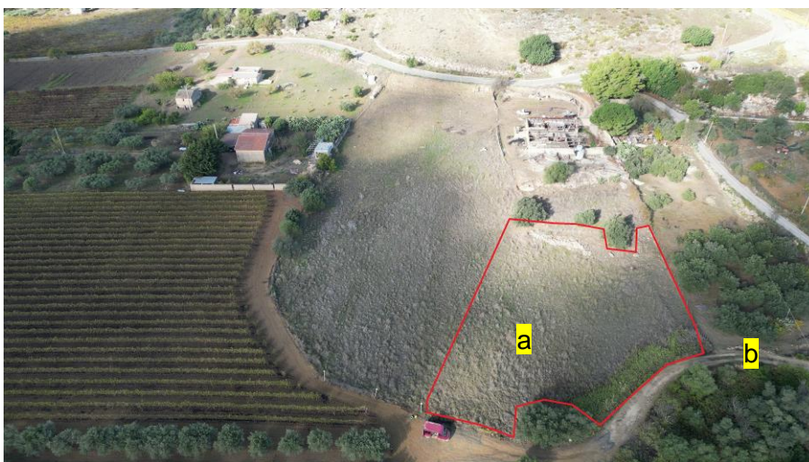
Foto aerea dell'area CO.03b: (a). area cantiere operativo CO.03b; strada di accesso all'area; (b). strada di accesso all'area.
