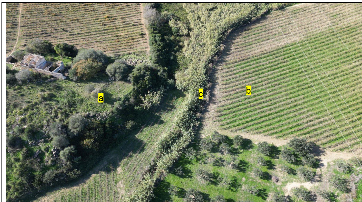
Foto aerea del Cantiere CO.20a: (a) area cantiere lato Petrosino (monte attraversamento); (b) area cantiere lato Marsala (valle attraversamento); (c) fiume Sossio
