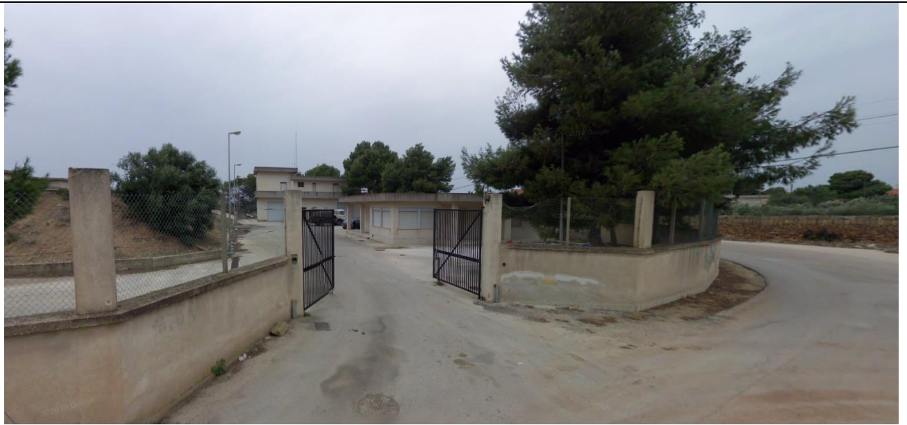
Foto ingresso all'area del Serbatoio Cardilla
