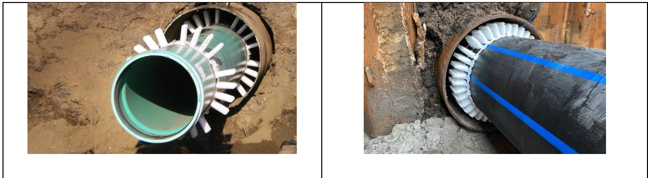
Distanziatori per tubazioni all'interno del tubo camicia
