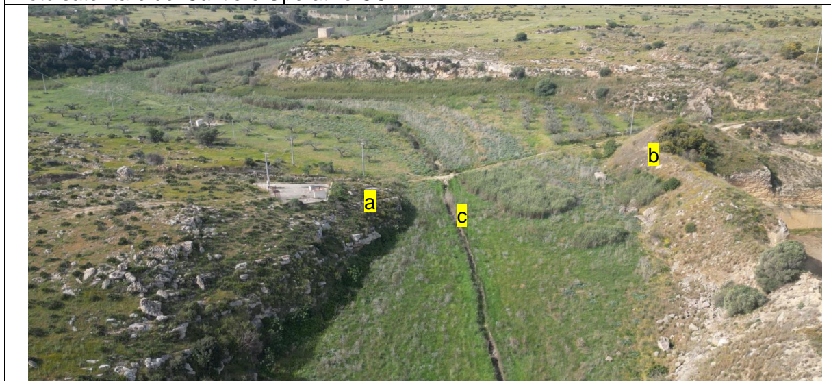
Foto aerea del Cantiere CO.17: (a) area cantiere sx idraulica (monte attraversamento); (b) area cantiere dx idraulica (valle attraversamento); (c) fiume Mazaro
