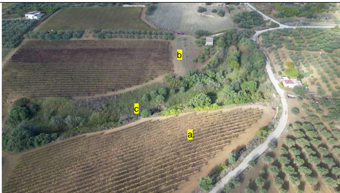
Panoramica del Cantiere Operativo CO.03. (a). area lato Menfi; (b). area lato Campobello di Mazara; (c). vallone Cava del Serpente
